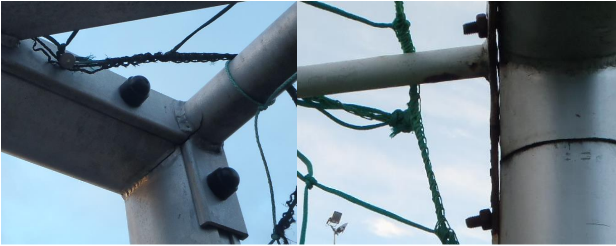
Kuvassa vasemmalla asiallisesti viimeistellyt runkopultit. Oikealla pitkiksi jääneet ja suojaamattomat päät.
