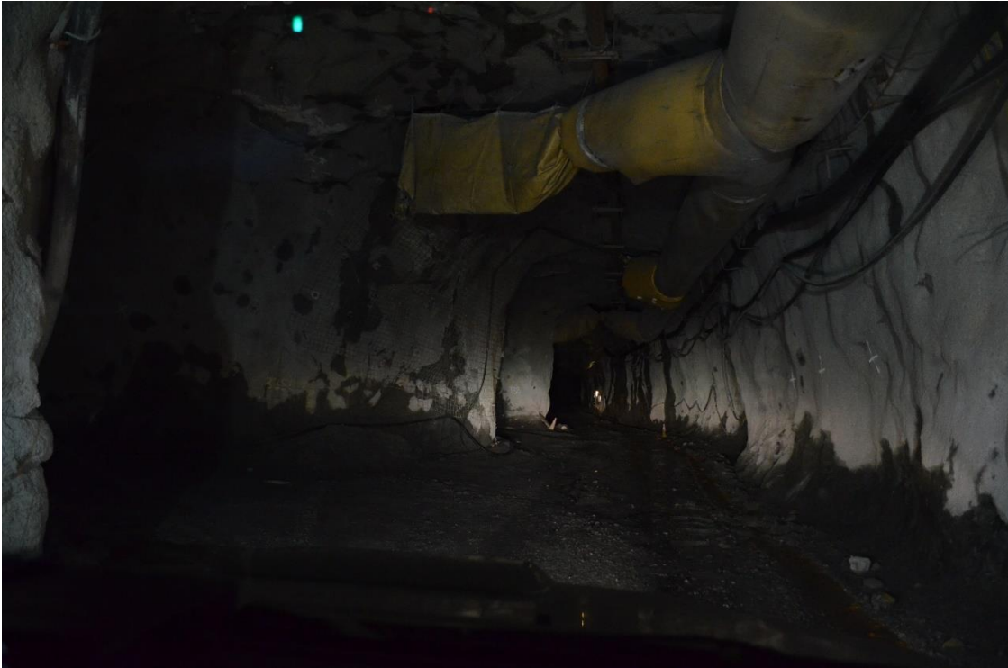
Kuva 2. Hieman yli puolesta välistä kuva tasoperältä 325 kohti avointa louhosta, kuvanottokohdasta matkaa suoraan eteenpäin louhokseen n.245 metriä. Kuva Tukes
