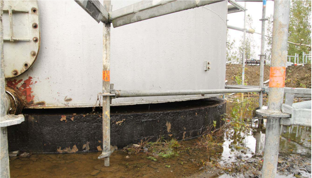
Kuva 7. Säiliön pohja pullistui räjähdyksessä.
