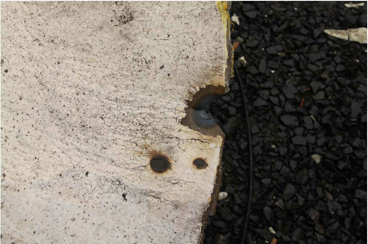
Kuva 9. Heftien hitsauksen aiheuttamat jäljet katon sisäpinnalla.
