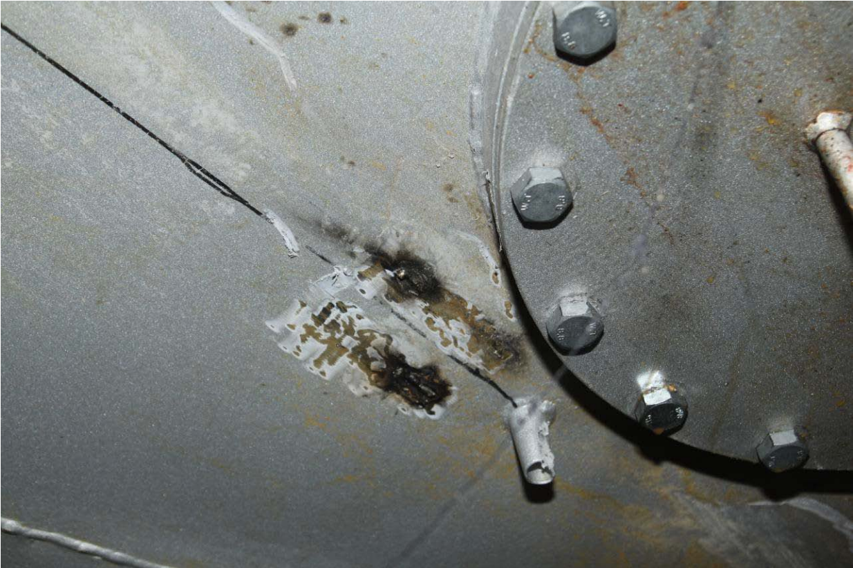
Kuva 10. Kuvassa kulmahiomakoneella hiottua katon ulkopintaa, pinnanmittausvaijerin yhde ja miesluukku.
