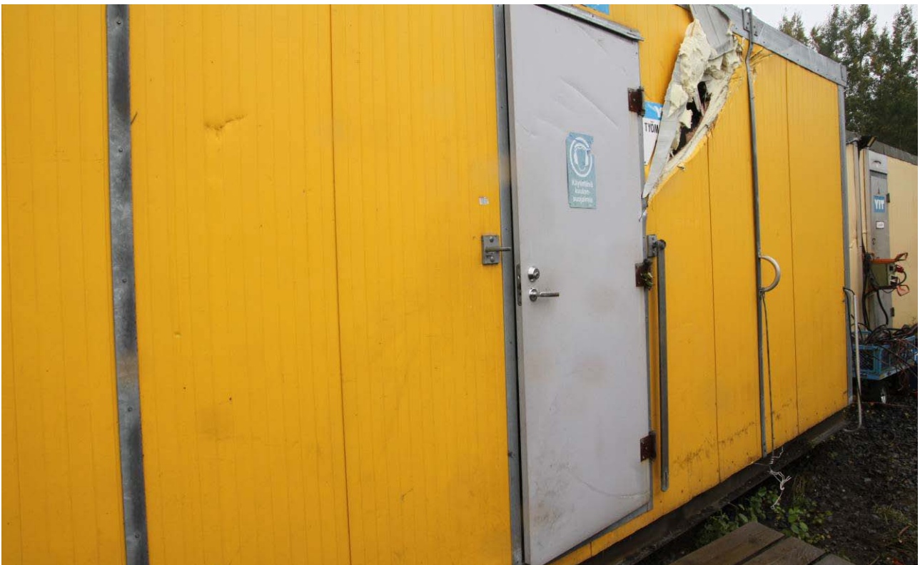
Kuva 6. Säiliön katto osui 85 metrin päässä olleen työmaakopin seinään.
