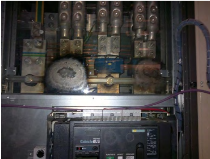
Kuva 29. Puutteellisen asennuksen aiheuttama oikosulku katkaisijan valokaaresta (© Juha Anttonen, Botnia Mill Service Oy).
