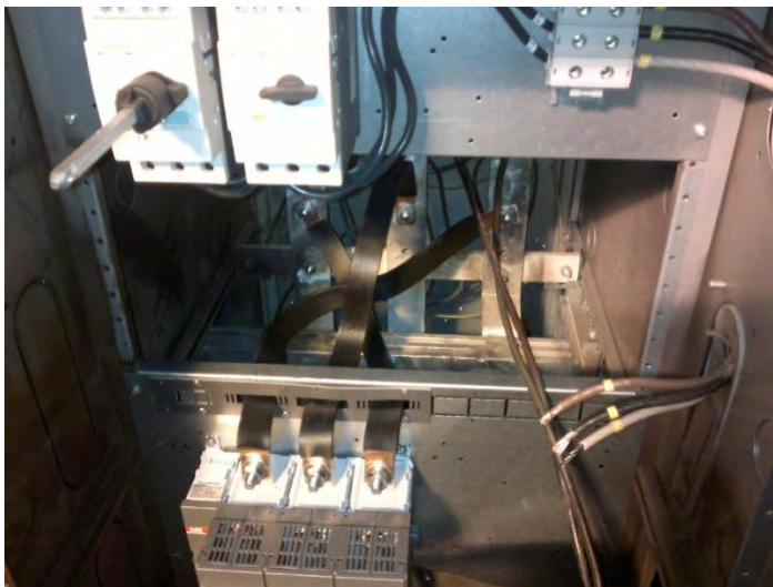
Kuva 30. Puutteellisten läpivientien aiheuttama maasulku keskuksen runkoon (© Juha Anttonen, Botnia Mill Service Oy).
