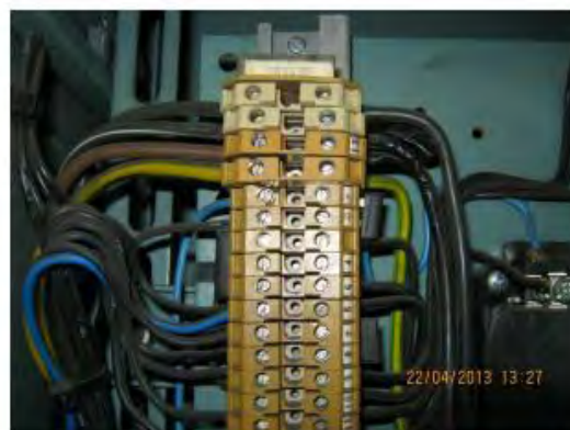
Kuva 42. Löystyneen riviliittinkytännän vaikutus johtimen ja liittimen lämpötilan nousuun (© Hannu Halminen, Bolden Harjavalta Oy).
