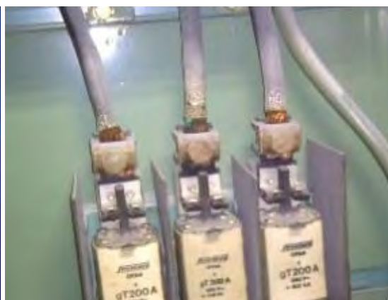
Kuva 44. Liitospintojen löystymisen aiheuttama lämmön nousu kahvasulakkeissa (© If Turvaakatemia).
