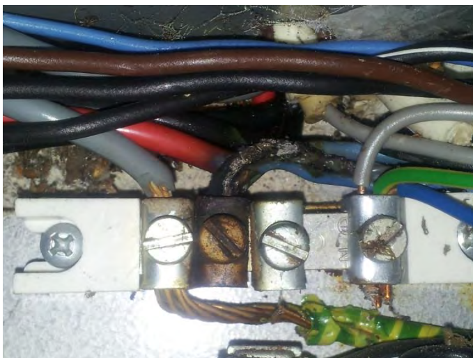
Kuva 22. Nollajohtimen liitoksen löystymisen aiheuttama vikaantuminen (© Marko Mäkeläinen, QM-Installation Oy).
