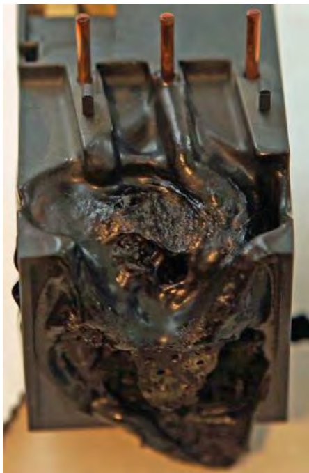
Kuva 33. Vaurioitunut kontaktori (© Jorma Korkalo, Primatest Oy).
