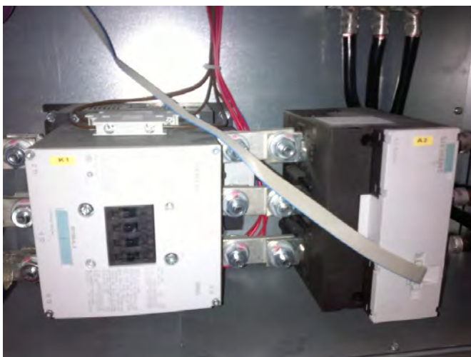
Kuva 32. Ohjausvirtapiirien väärä kaapelointireitti aiheuttaa pää- ja ohjausvirtapiirien välisen oikosulun riskin (© Juha Anttonen, Botnia Mill Service Oy).
