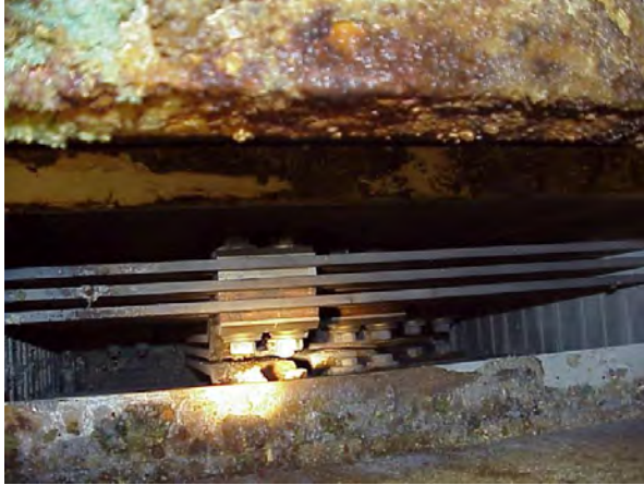
Kuva 25. Happaman nesteen vaikutukset jakokeskuksen kiskostoon (© Hannu Halminen, Bolden Harjavalta Oy).
