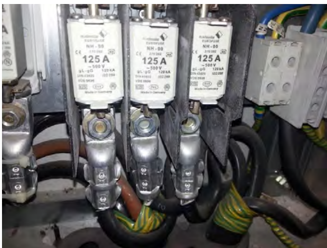
Kuva 28. Pulttiliitoksen vaillinaisen viimeistely, pultti on liian lyhyt (© Pertti Kukkonen, Oy Elspecta Ab).
