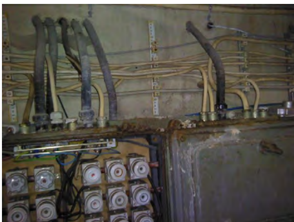
Kuva 24. Yläpuolen putkistoista vuotaneen veden ruostuttama jakokeskus (© If Turva-akatemiat).
