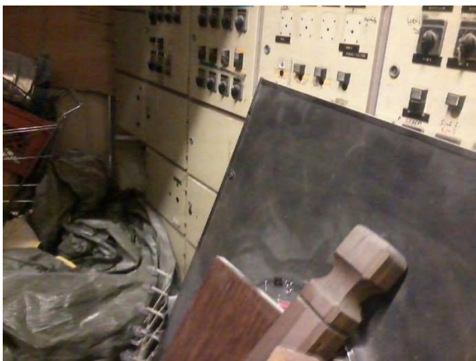
Kuva 37. Ylimääräinen tavara estää laitteistojen kunnossapidon ja lisää tilan palokuormaa huo- mattavasti (@ Pertti Kukkonen, Oy Elspecta Ab).
