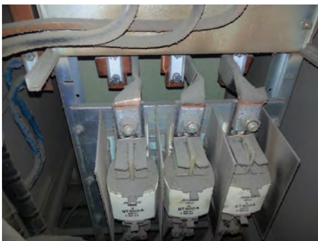
Kuva 35. Pölyä ja likaa on kertynyt runsaasti jännitteisille pinnoille keskuksen sisälle (© Pertti Kukkonen, Oy Elspecta Ab).
