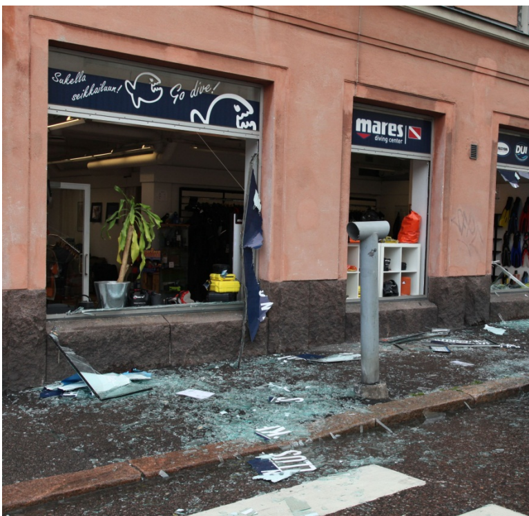
Kuva 3. Onnettomuuspaikan ikkunat ovat hajonneet
