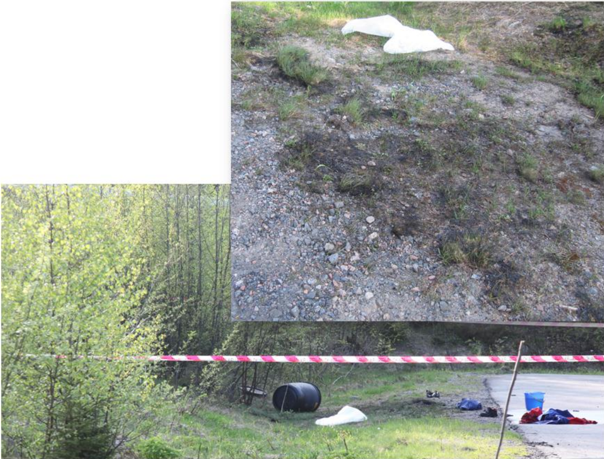
Kuva 5. Palojälkiä rakennuksen ulkopuolella. Palon aiheuttamat kasvustovauriot ulottuivat rakennuksen etupuolella noin 19 metrein etäisyydelle ja takapuolella noin 10 metrin etäisyydelle.
