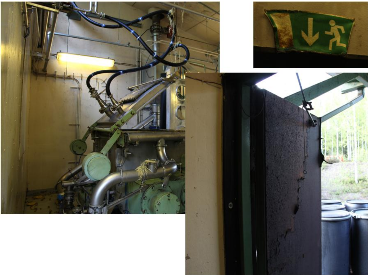
Kuva 3. Sekoitin kuvattuna sivulta palon jälkeen ja sekoitinhuoneen takaoven palojäljet.
