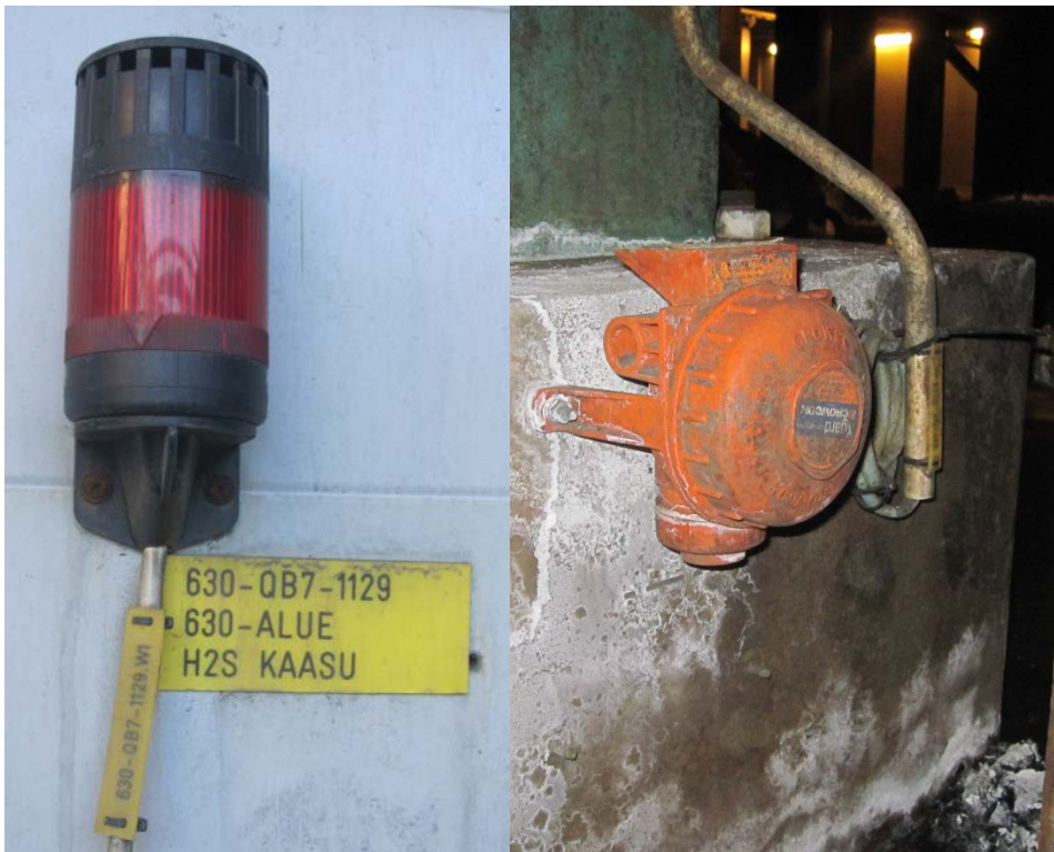
Kuva 11. Kiinteän rikkivetytunnistimen hälytyslaite (vasemmalla) ja mittauslaite (oikealla).
