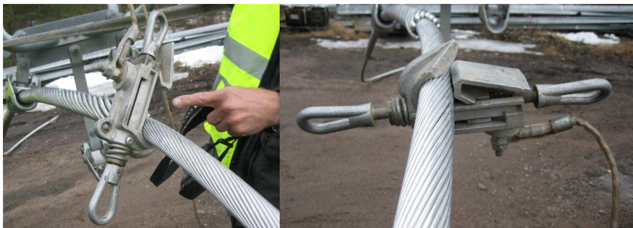
Kuva 7. Vasemman puoleisessa kuvassa on vaiheliitin tiukattuna vetämällä maadoitusköyden varaan kiinni johtimeen. Oikeanpuoleisessa kuvassa on esitetty oikea kiinnitystapa.
