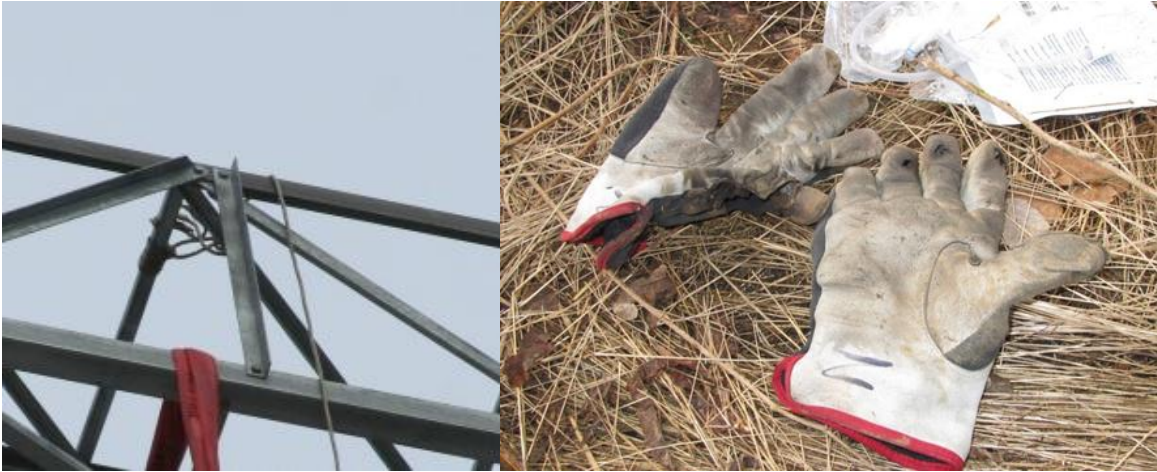
Kuva 6. Vasemmalla työmaadoitusvälineen köysi solmittuna orren yläpaarteeseen. Oikeanpuoleisessa kuvassa uhrin työssä käyttämät käsiineet.
