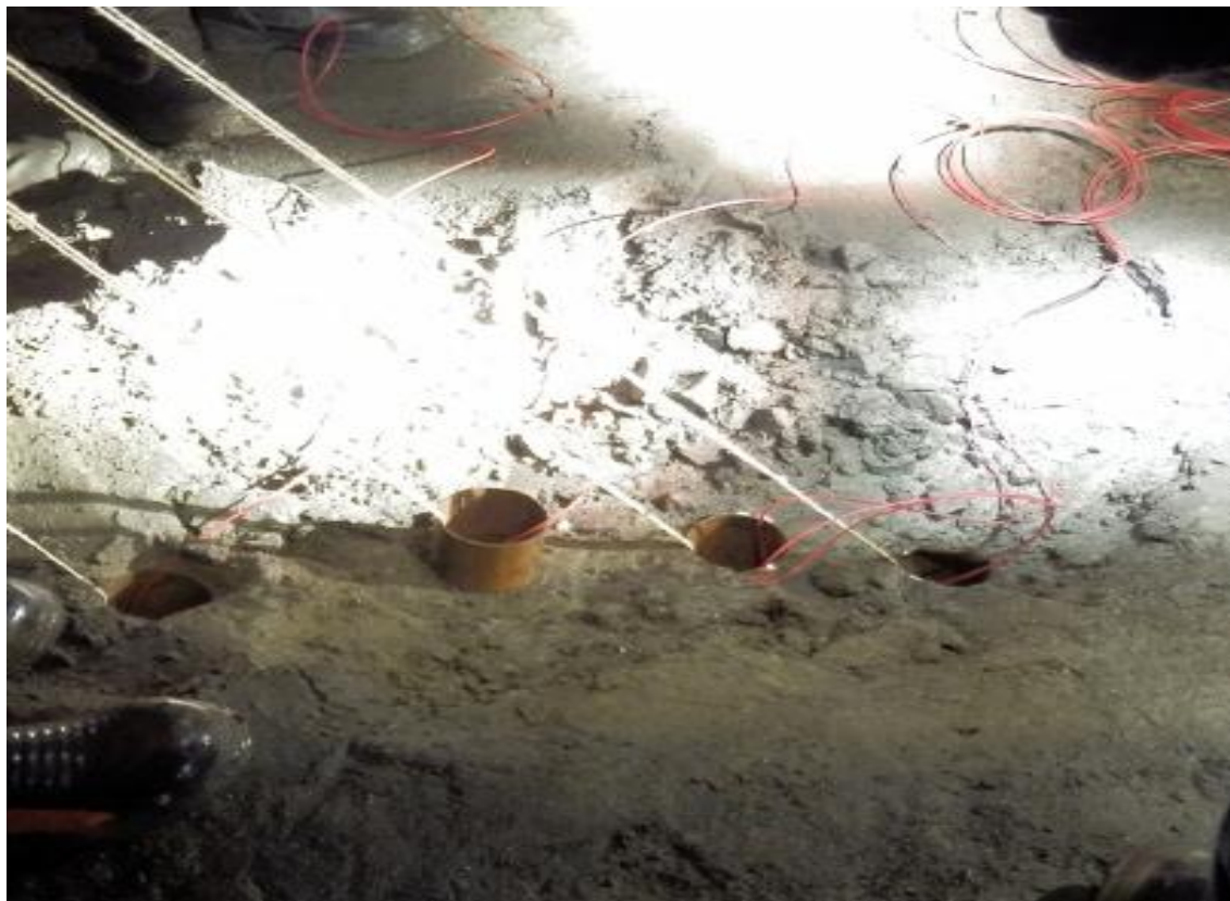
Kuva 2: Alakätisten reikien panostus käynnissä Pyhäsalmen kaivoksessa 1
