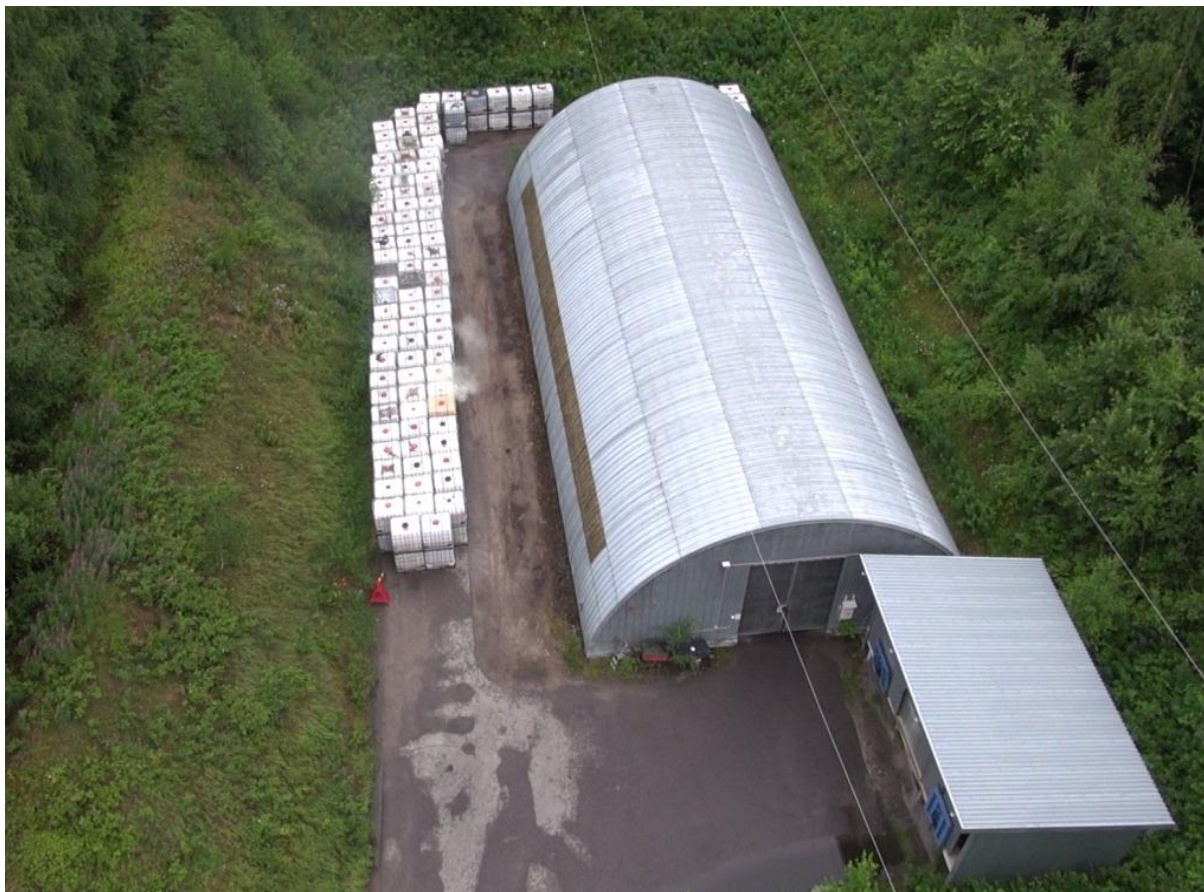
Kuva 3: Räjähdevarasto 312 onnettomuushetkellä. Kuvassa näkyy höyryävä IBC-pakkaus.
