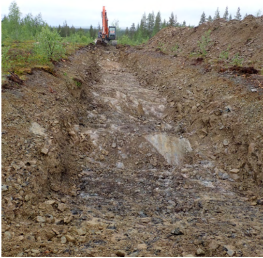
Juuri avattu tutkimuskaivanto. Kuva: GeoPool Oy.
