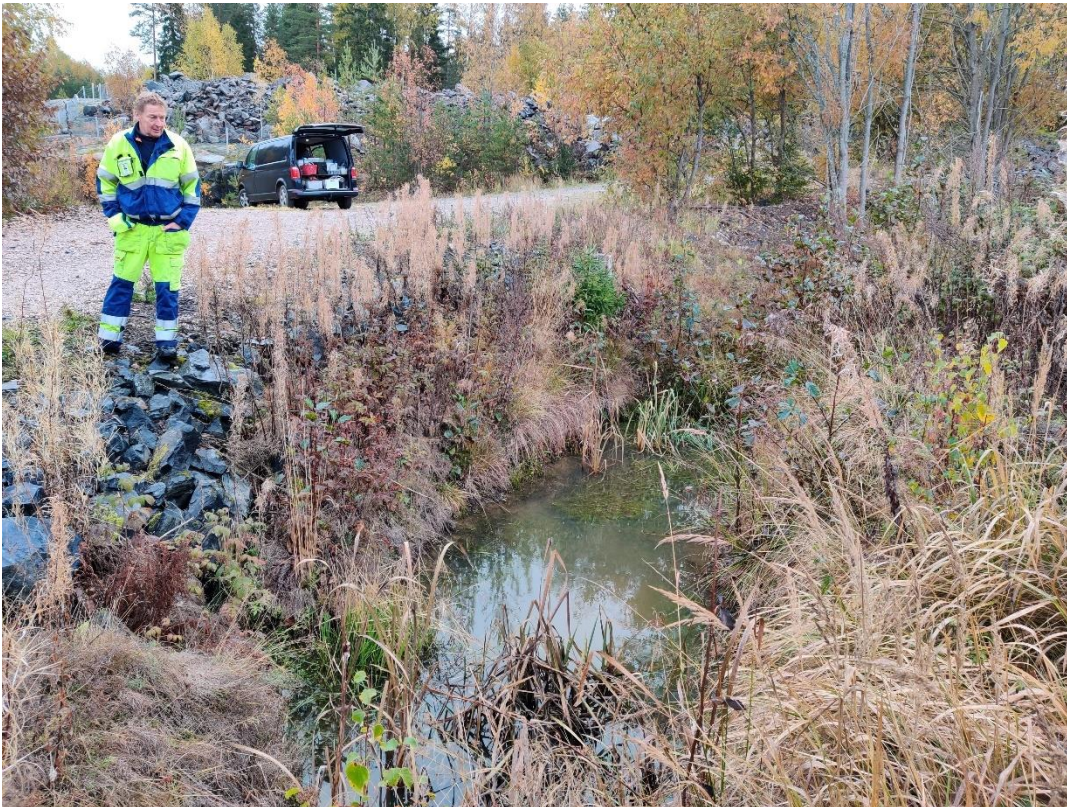
Kuva 2. Alueelle tuleva oja ja louhoksen läjitysalueen kivikasa taka-alalla.
