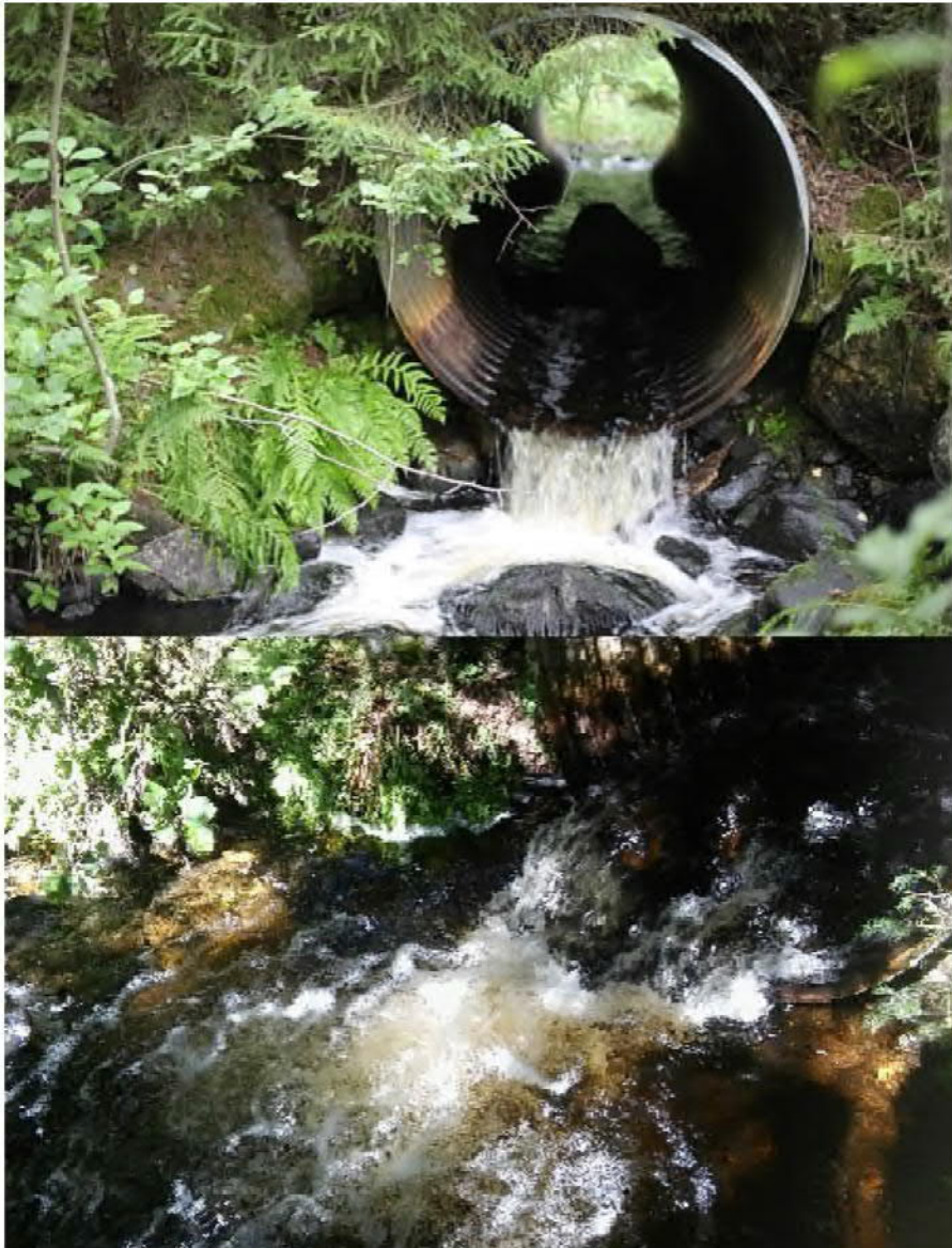
Kuva 1. Myllyjoen tierumpu ennen/jälkeen kunnostuksen
