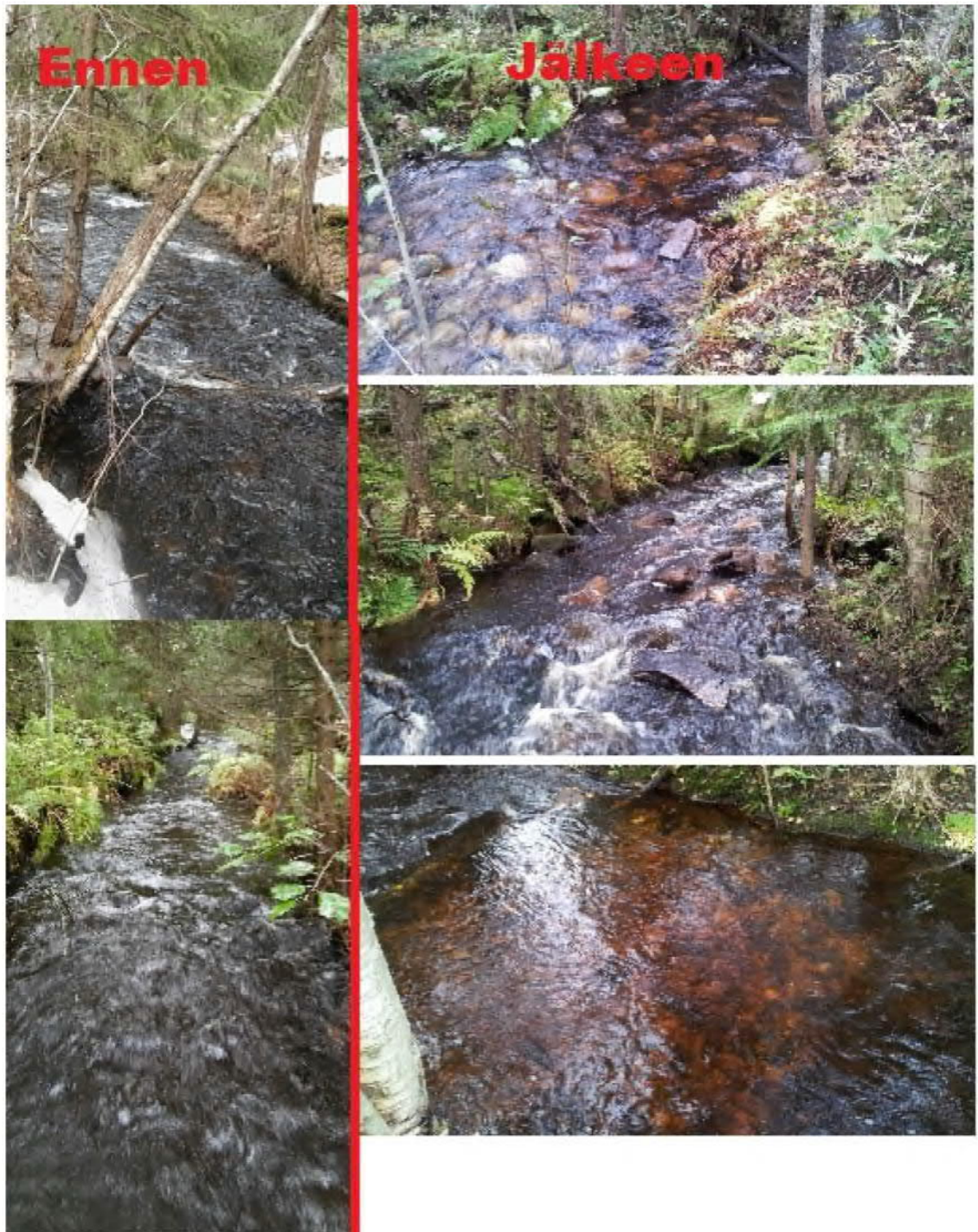
Kuva 5. Koirajokea ennen kiveämistä (vasemmalla) ja kiveämisen ja soraistamisen jälkeen (oikealla)
