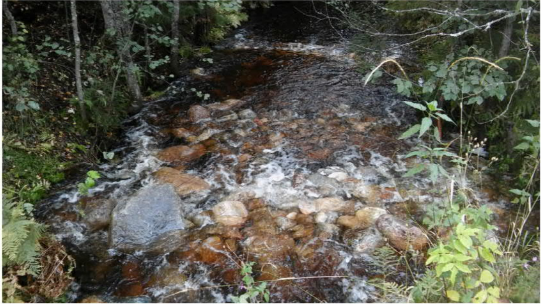
Kuva 4. Koirajoen siltarumpu alavirran suuntaan kuvattuna
