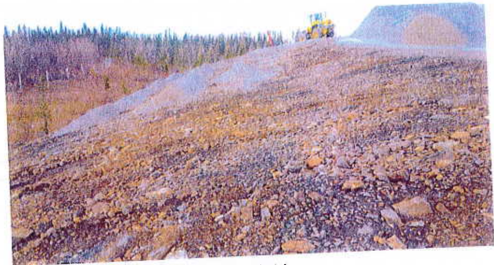
Kuva 4. Alustan tasoitus 5.11.2016, yleisvaikutelma.
