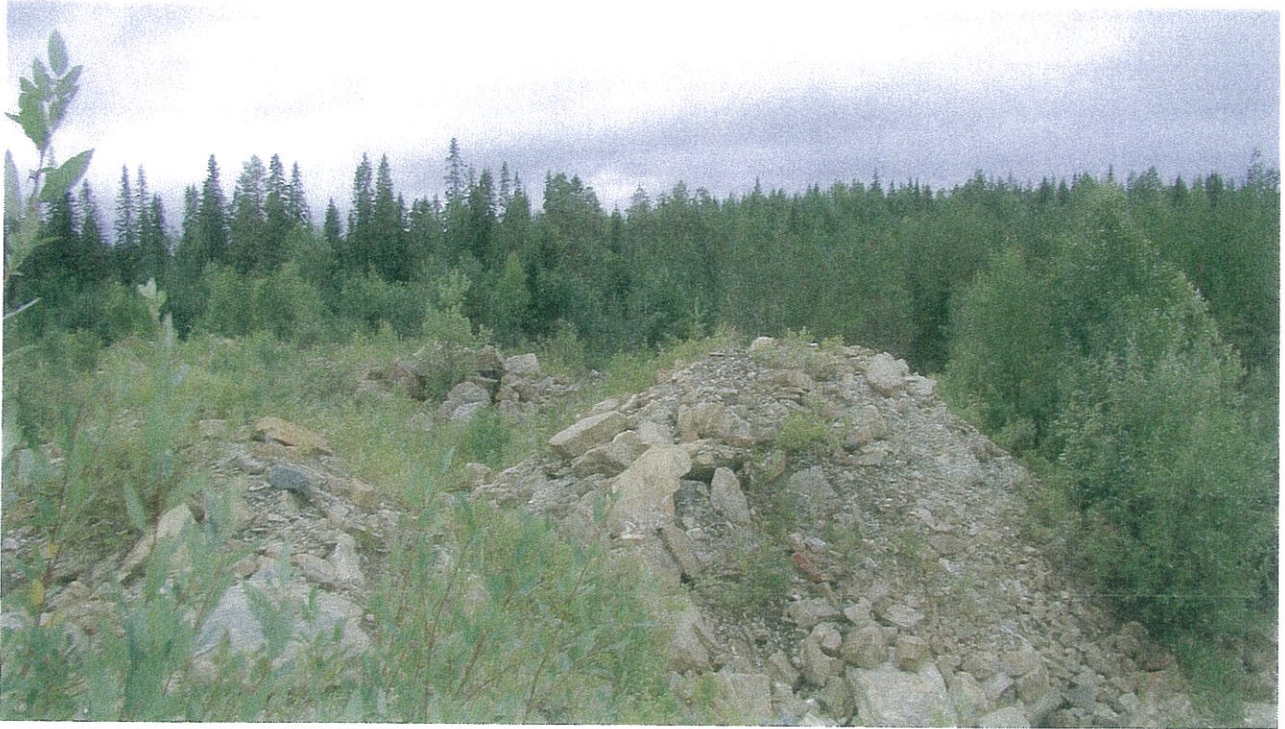
Kuva 7. Sivukivikasoja, jotka vaativat loiventamista kaivinkoneella.
