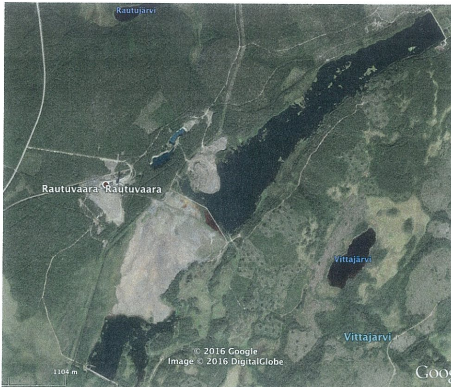
Kuva 3. Rautuvaaran alue. Kuvassa näkyy jätealue ja Niesajokeen tehdyt patorakennelmat ja altaat sekä avolouhokset ja sivukivikasa.
