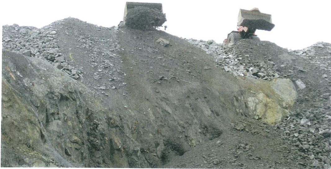
Kuva 4. Avolouhoksen sivukivitäyttö
