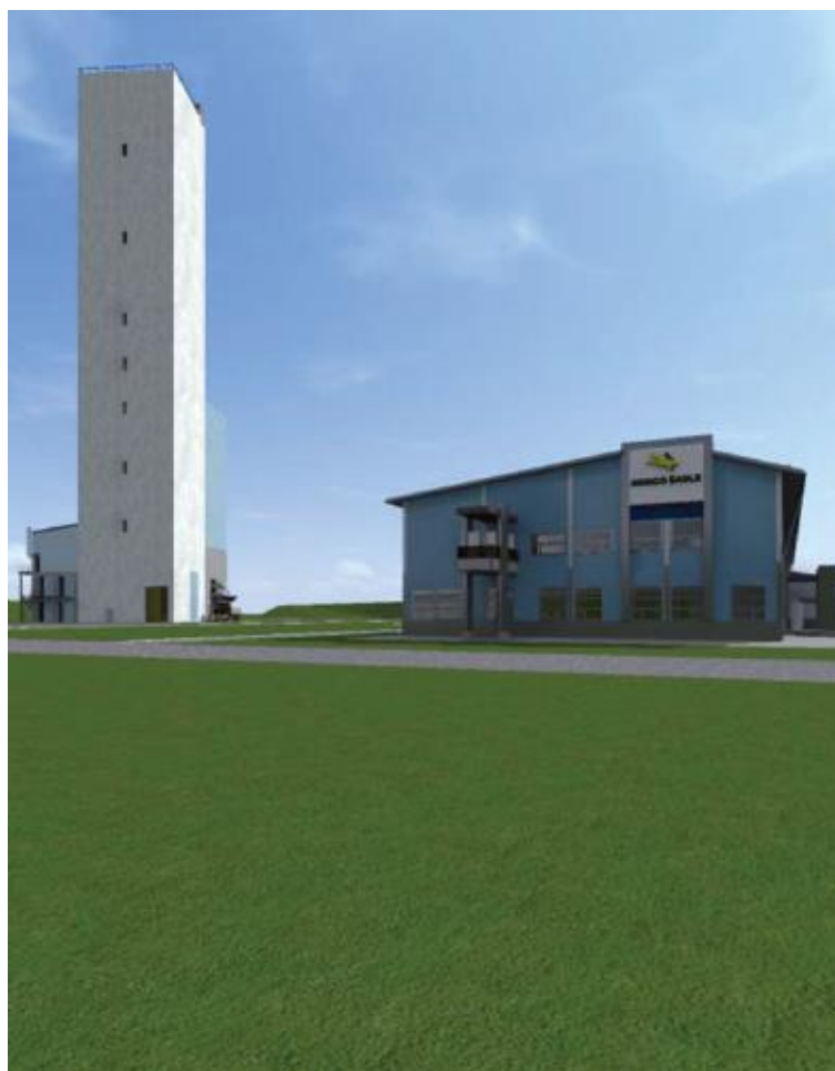
Kuva 1-2. Suunnitellun nostokuilun ja nostotornin (kuvassa vasemmalla) sijainti uuden kaivoskonttorin läheisyydessä (Pöyry 2016). Nostotornin korkeus on noin 93 metriä.
