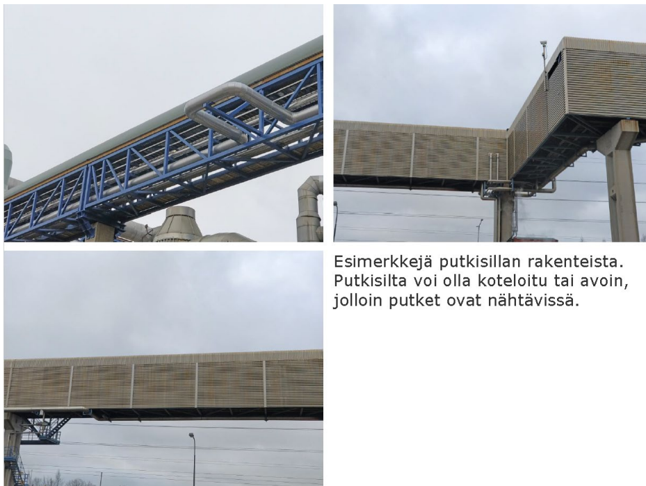
Kuva 7-22. Esimerkkejä putkisillan rakenteista.
