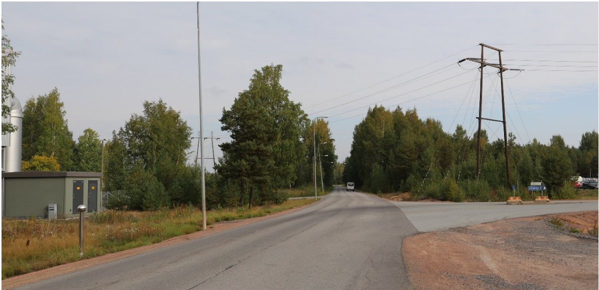
Kuva 7-9. Torttilantien näkymä pohjoisen suuntaan. Kuvassa oikealla Suurteollisuuspuistolle johtava Länsitie. Torttilantien asuinuue sijoittuu kuvassa oikealla olevan metsäalueen taakse. Kuva otettu 6.9.2018.
