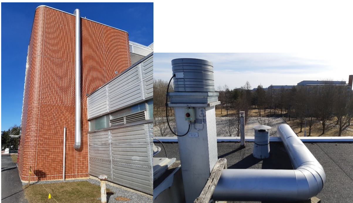
Bild 5. Utblåsningen av avluften från kemikalielokaler placerad på simhallens tak.
