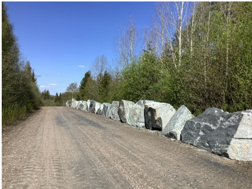
Kuva 1. Tulikivi Oyj käyttää louhoksien aitaamisessa kiviaitaa (Tukes 26.5.2025)
