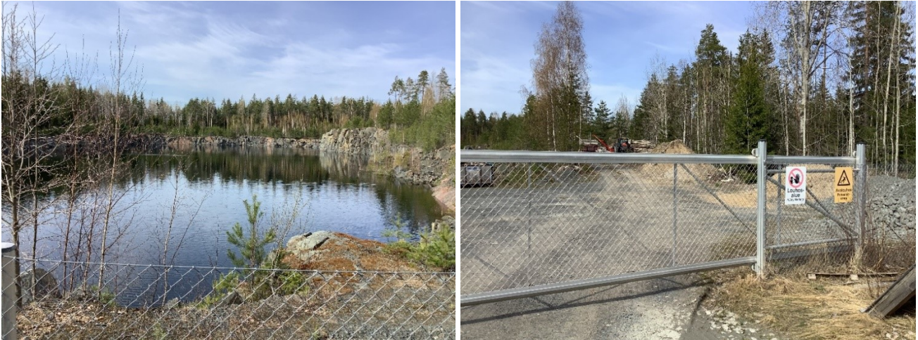
Kuvat 1 ja 2: Vedellä täyttyneen Vanhasuon louhoksen aitausta, portti ja varoituskylttejä (Tukes 9.5.2023)
