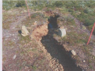
Kuva 1.4 Kaivu-ura kohti puroa.
