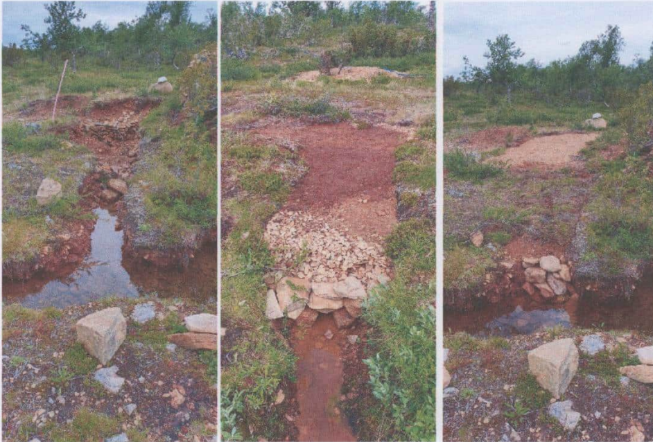
Kuva 2.2 Kaivettu koemonttu ja sen ennallistaminen.
