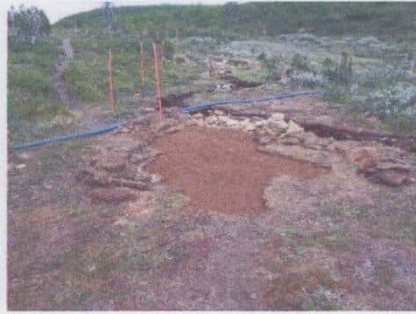
Kuva 2.7 Sorakerros kivien päälle.
