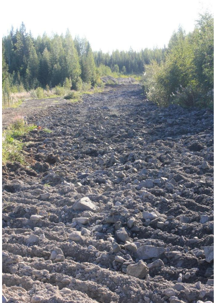
Kuva 8 Ilmanvaihtokuilulle johtava tie, josta sivukivimateriaalia poistettu
