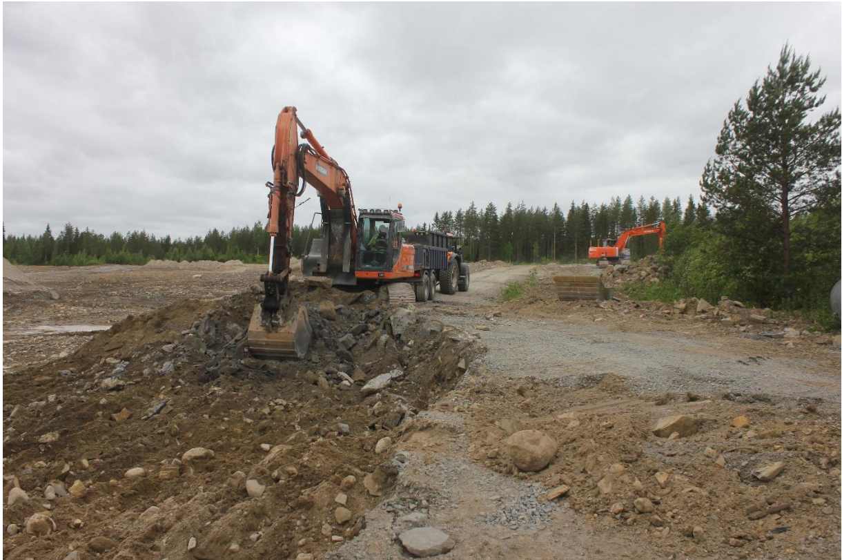
Kuva 9 Sivukiven poistamista kaivinkoneella sivukiven varastoalueelta
