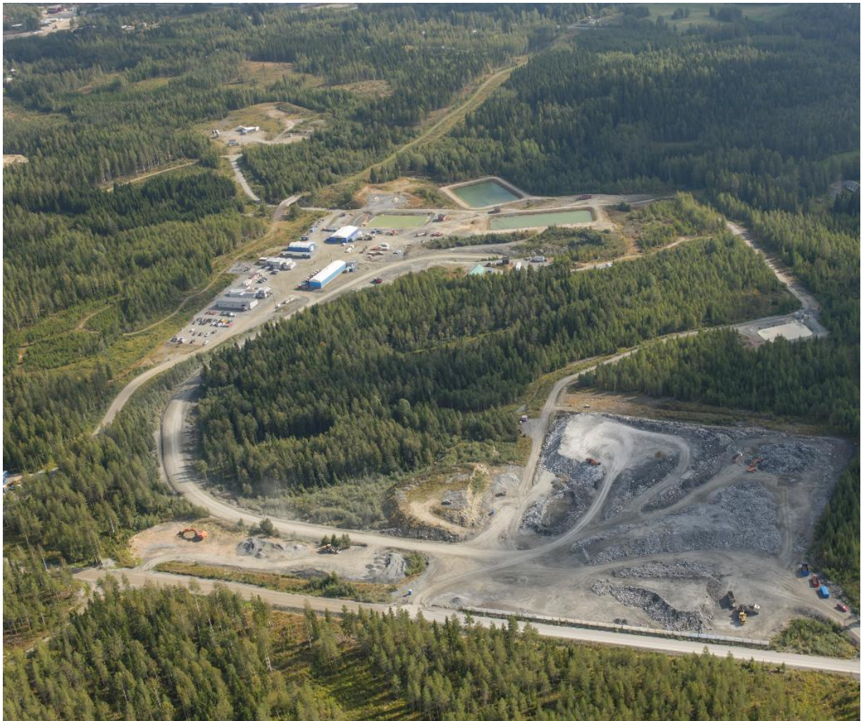
Kuva 26 Kaivosalue ennen jälkihoitotoimenpiteiden aloittamista 2019
