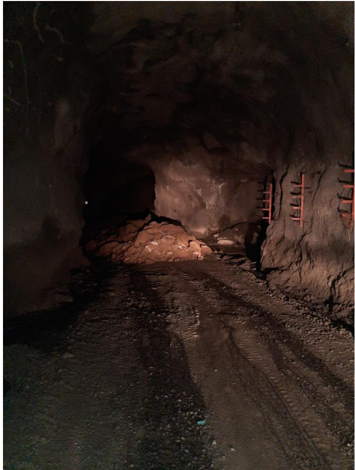
Kuva 6 Vinotunneli purkutoimintojen jälkeen, jäljellä teräksiset kannattimet
