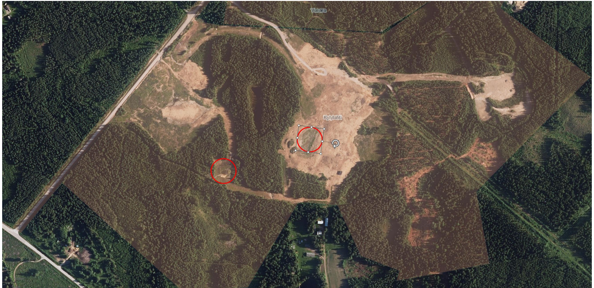
Kuva 5 Rakennetut kosteikkoalueet (kaivospiirialue rasteroituna).
