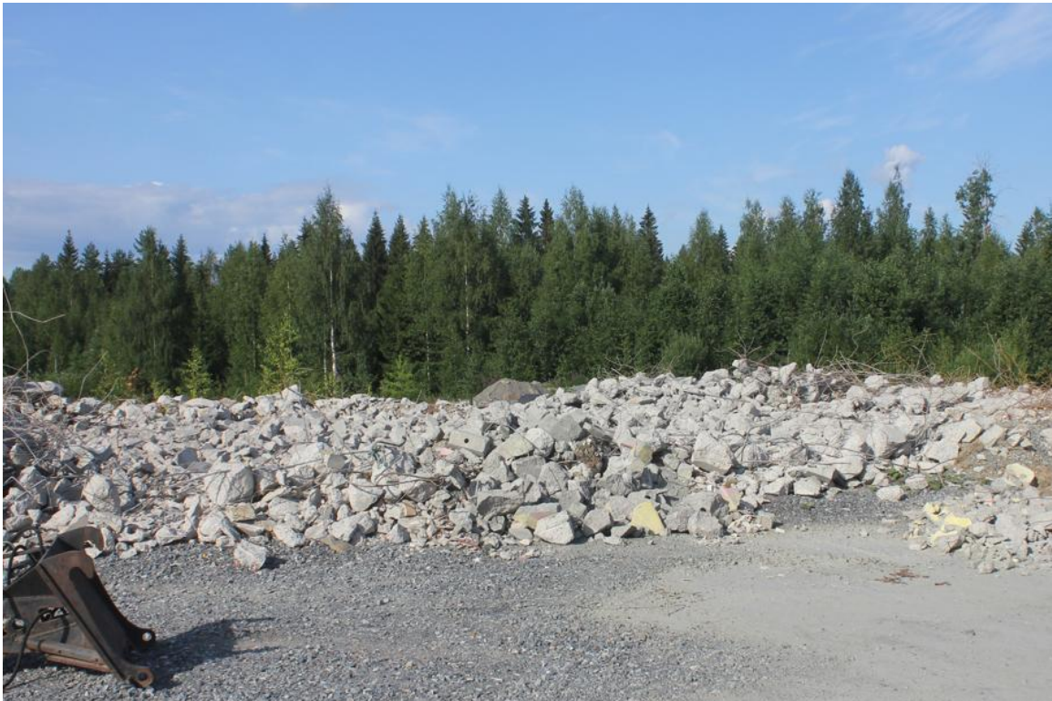
Kuva 25 Murskattu betonilaatta odottamassa pulverointia
