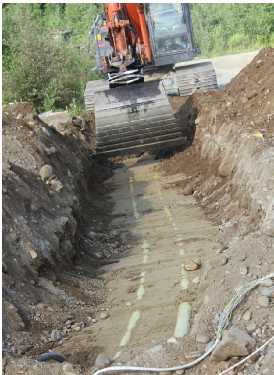
Kuva 22 Sähköjohtimien poistamista ilmanvaihtokulualueella
