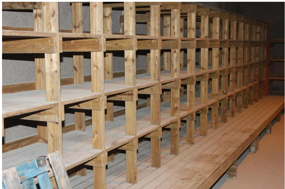
Kuva 7 Tyhjennetty varasto, puiset varastohyllyt jätetty paikalleen
