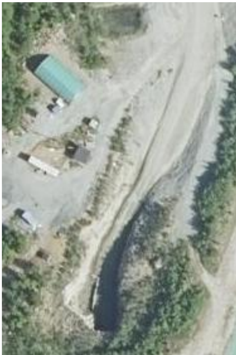
Kuva 17 Ilmakuva maanalaisiin tiloihin johtavalle vinotielle maanpinnalta.
