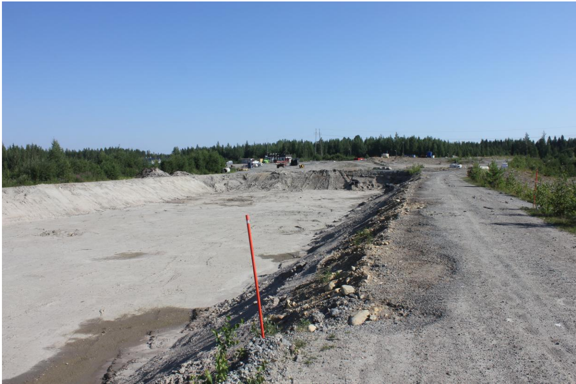
Kuva 12 Tyhjennetty vesien käsittelyallas, josta poistettu bentoniittimatto ja pilaantunut maa-aines
