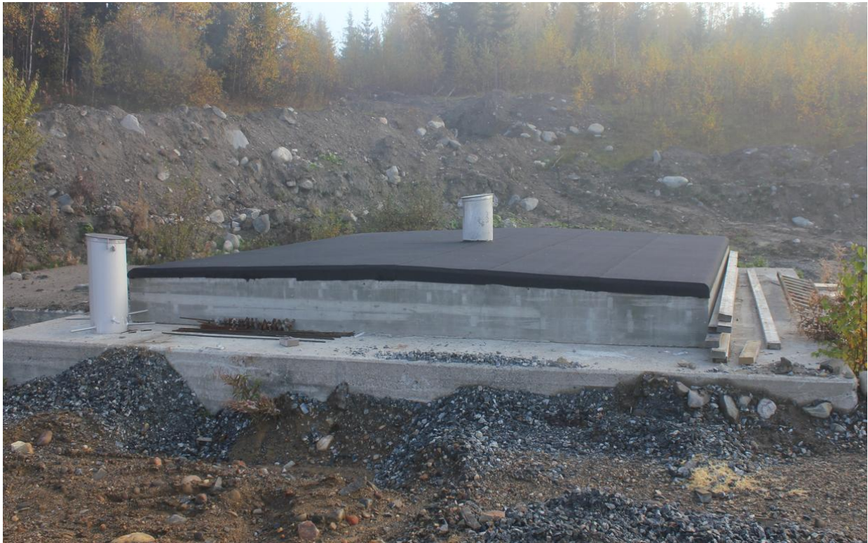
Kuva 16 Betonikansi poistoilmakuilun päällä
