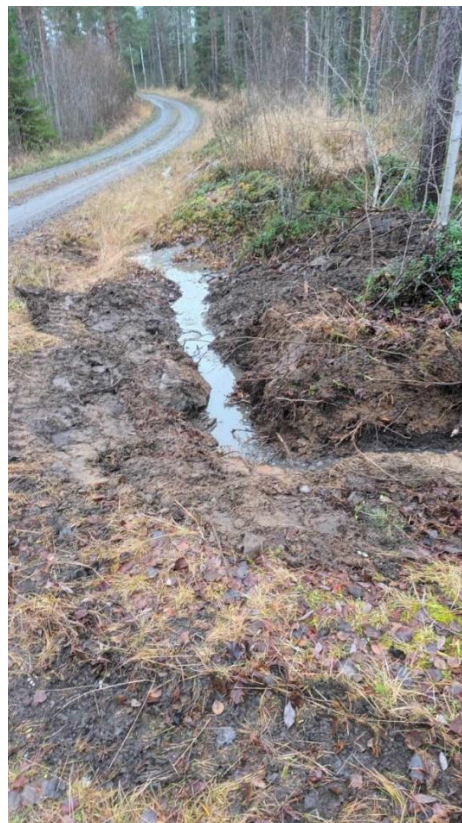
Kuva 2. Ojan liittymä louhostien ja Rytisuontien risteyskohtaan (kuva Paroc Oy Ab).
