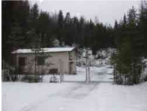
Kuva 6.1.3. Syvänsin vedenottamo. Kuva: Elina Lindsberg, 14.12.2011.
