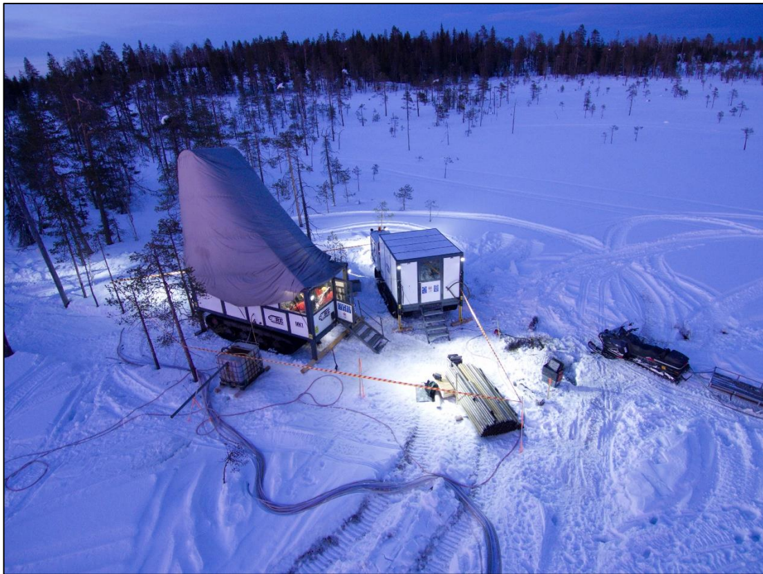
Kuva 25: Timanttisyväkairauslaitteisto ja vedenpuhdistuskontti (Huom! Kuva Natura-alueen ulkopuolelta)
