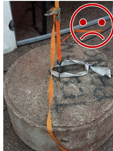
S-kroken lossnar när konstruktionen fjädrar i vinden. Fästningen är inte låst vid fästpunkten.
