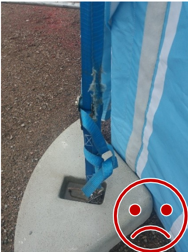
Spännbandet är slitet.
