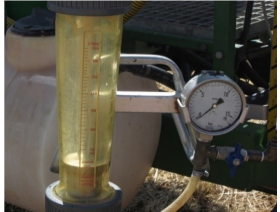
KUVA 12. Pumpun tuoton ja mahdollisen ilmapuodon näkee virtausmittarilla.
