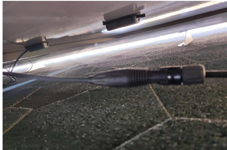
Tasasähkökaapeleita ja liittimiä kiinnitetty puutteellisesti ollen vaarassa vaurioitua.
