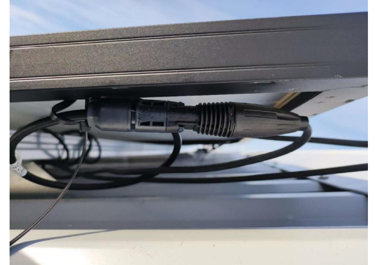
Tasasähkökaapeleita ja liittimiä kiinnitetty puutteellisesti ollen vaarassa vaurioitua.
