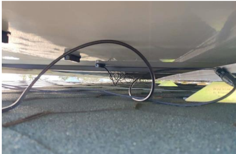
Tasasähkökaapeleita ja liittimiä kiinnitetty puutteellisesti ollen vaarassa vaurioitua.
