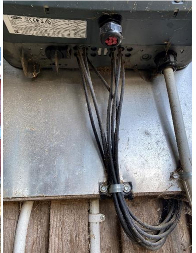
Vaihtosuuntaaja - invertteri asennettu palovaaralliseen ympäristöön ja on karjan kosketeltavissa.
