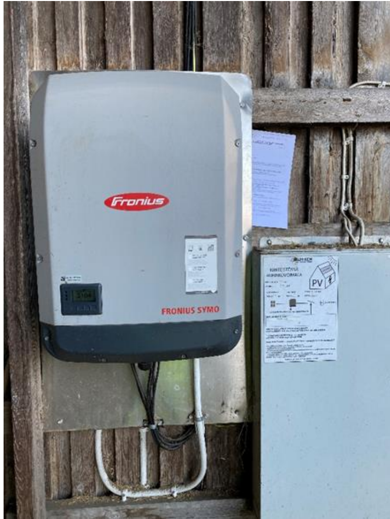
Vaihtosuuntaaja - invertteri asennettu palovaaralliseen ympäristöön ja on karjan kosketeltavissa.
