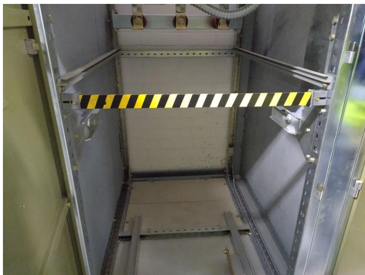
Kuvat 9. ja 10. Katkaisijavaunu ja varaus mittauskennolle kiskolla 1B
