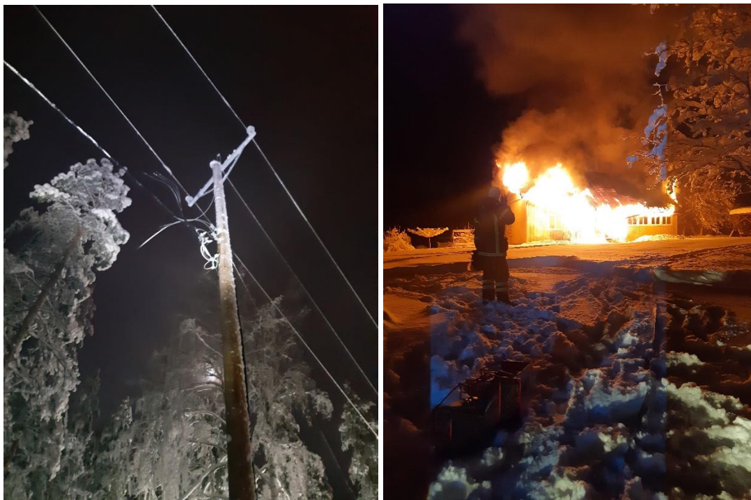
Kuvat 1. ja 2. Vaurioitunut avojohto ja onnettomuuden seurauksena palava rakennus.
