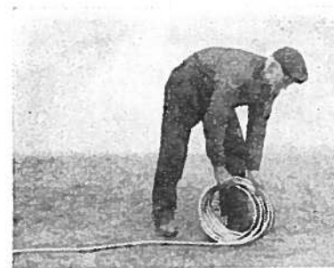
Kuva 32. Oikea köyden vapauttamistapa vyyhdeltä.
