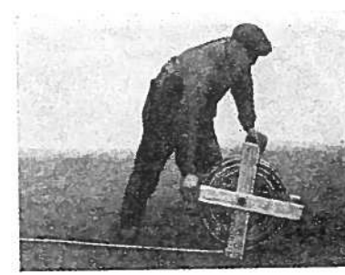
Kuva 33. Oikea köyden vapauttamistapa ristikkokelalta ilman jalustaa.
