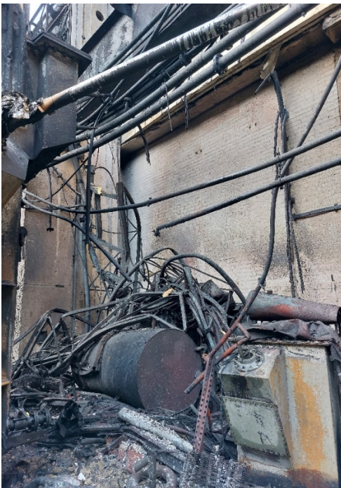
Kuvat 7., 8.,9. ja 10. Tukesin ottamia valokuvia paisuntaöljylinjasta ja paisuntaöljysäiliöstä
