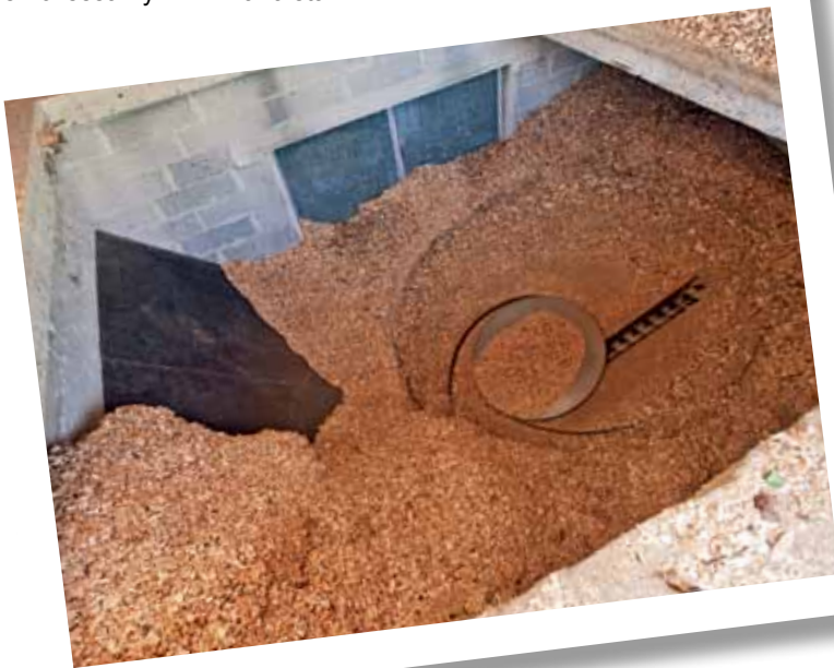
Hakevarastossa jousipurkain syöttää haketta ruuville.
