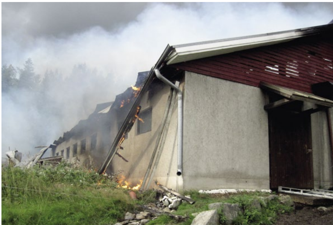
Tulipalossa tuhoutunut maatalouden rakennus. Ennakoivalla kunnossapidolla ehkäistään vahinkojen syntymistä.
