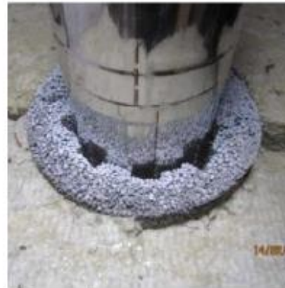
Kuva 4: Läpivientisuoja asennettuna eristeisiin.
