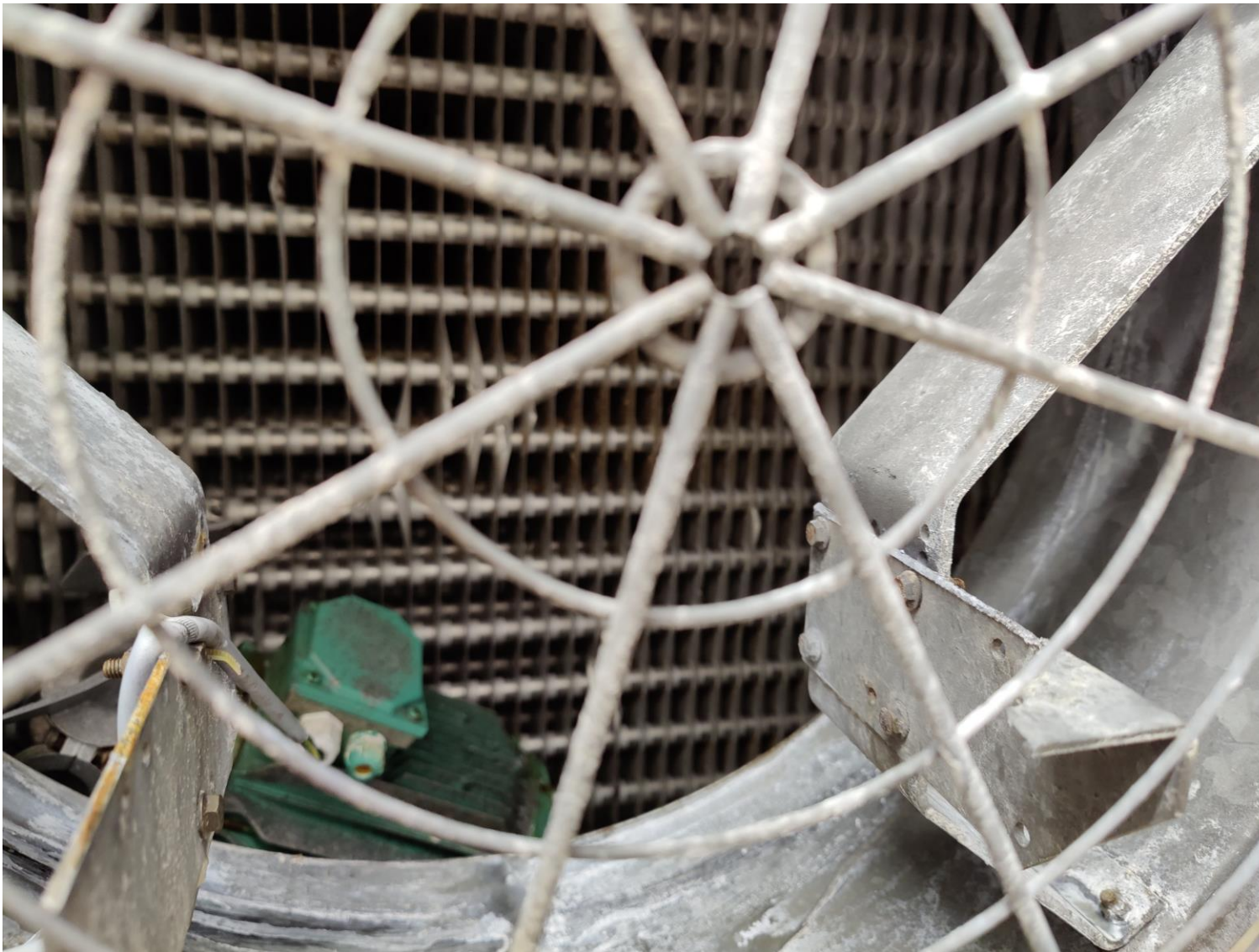
Kuva 8 (yritys): Ironnut puhallinmoottori
