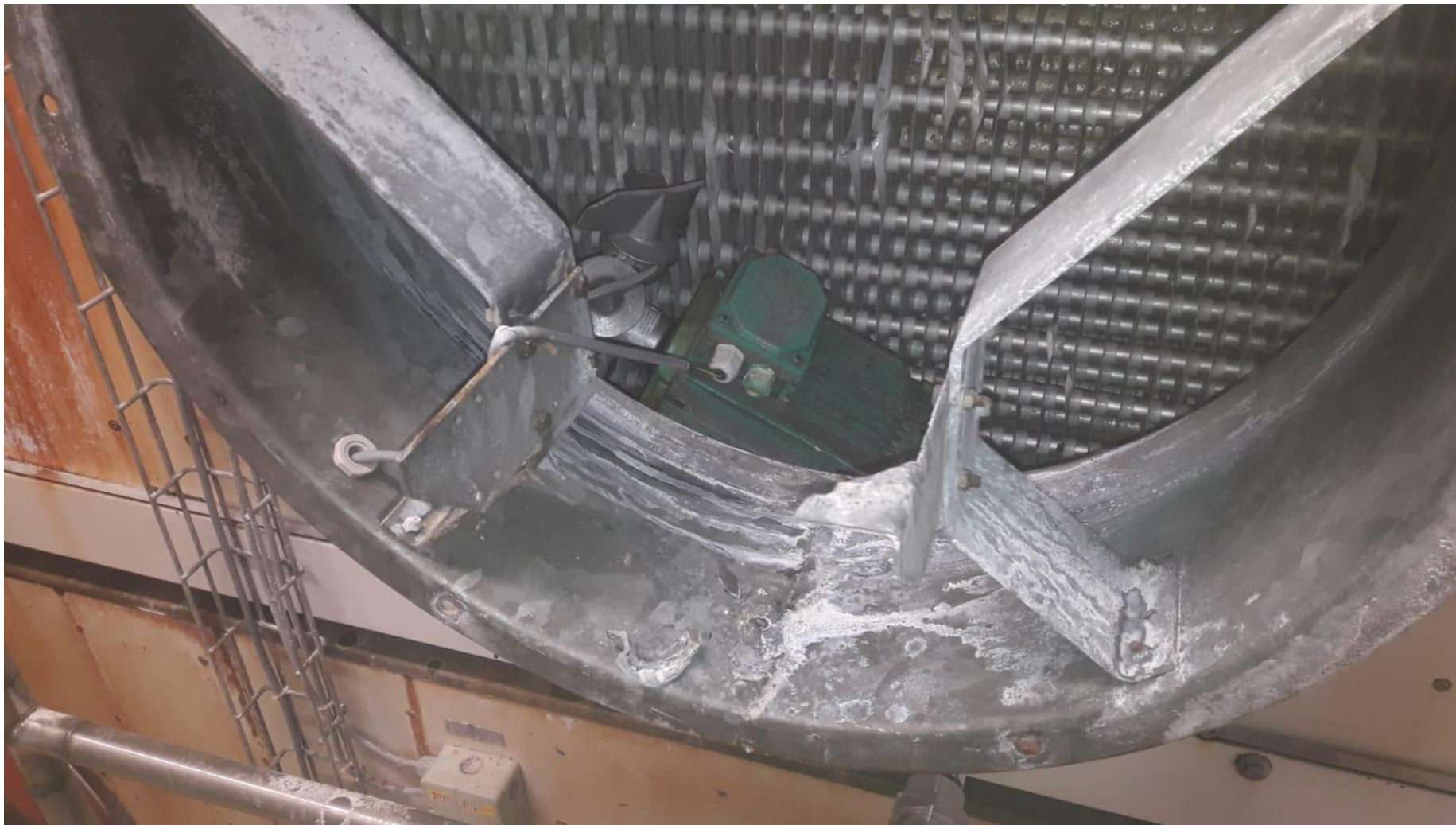
Kuva 9 (yritys): Ironnut puhallinmoottori
