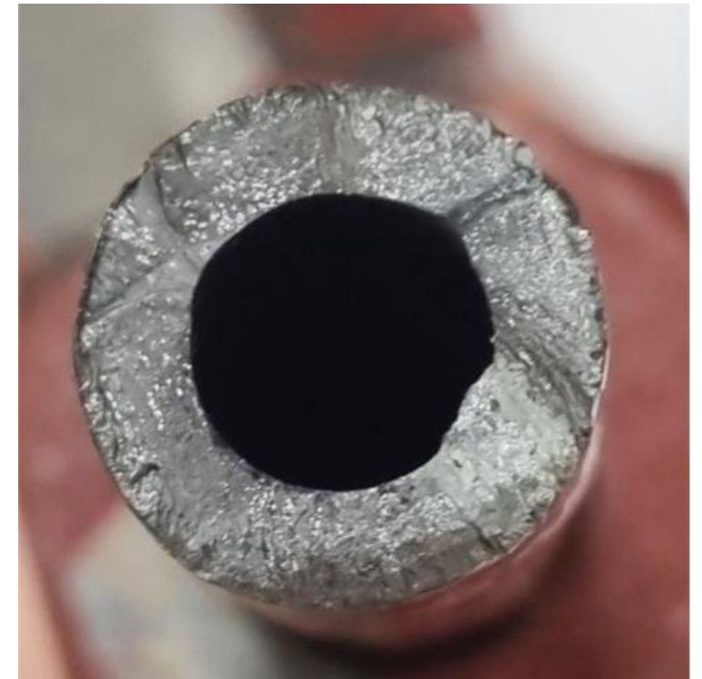
Kuva 3. Huoltoventtiilin putken murtumakohta, putken halkaisija 13,5 mm.
