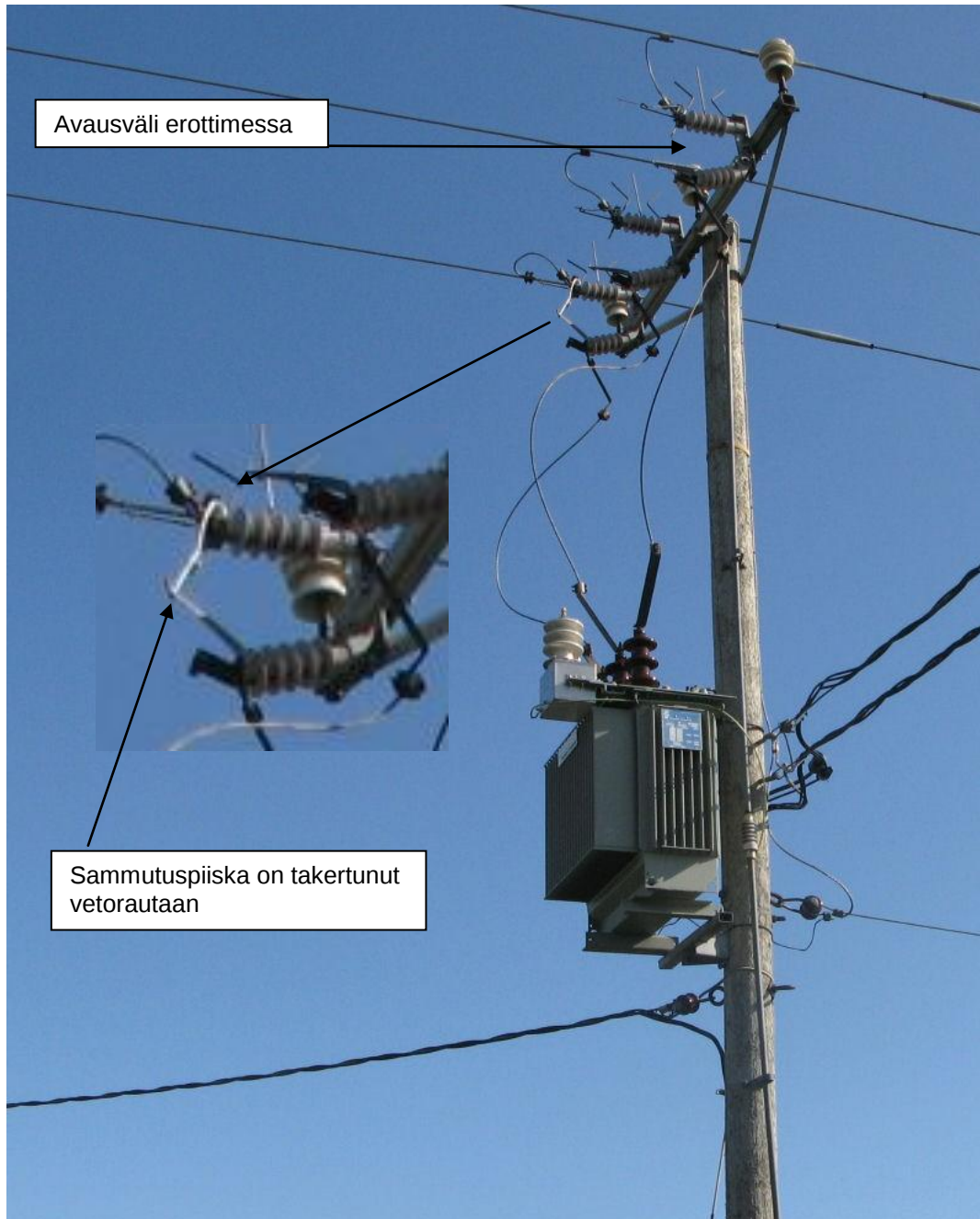
Kuva 3. Erottimen sammutuspiiska on takertunut vetorautaan (Poliisin kuvasta)
