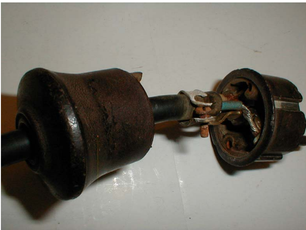
Kuva 2 Vioittuneen jatkojohdon pistotulppa. Pistotulppa oli kytkettynä kuvan 1 pistorasiaan.
