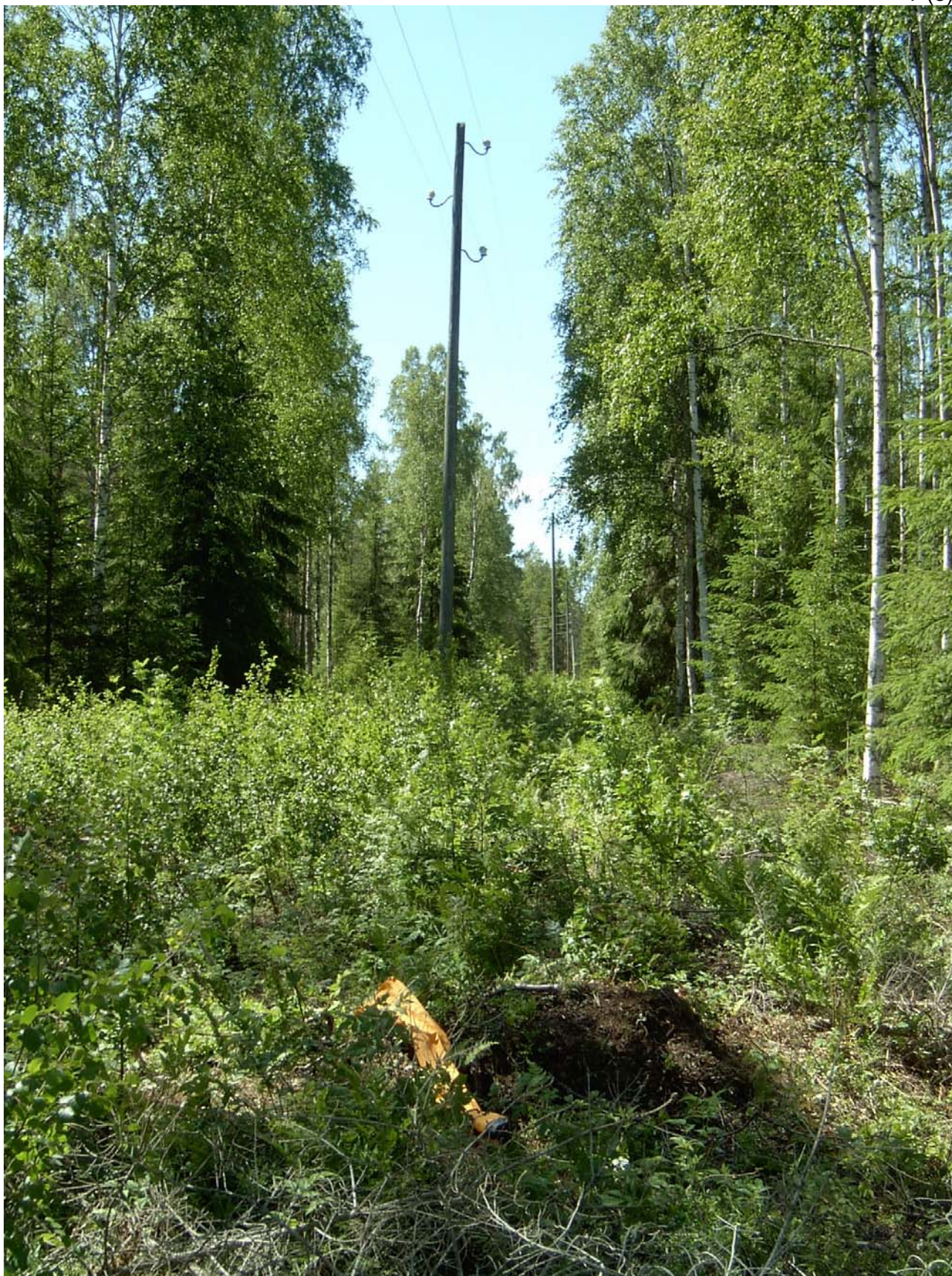
Kuva 1 20 kV avojohto. Uhri on maannut keltaisen merkin kohdalla
