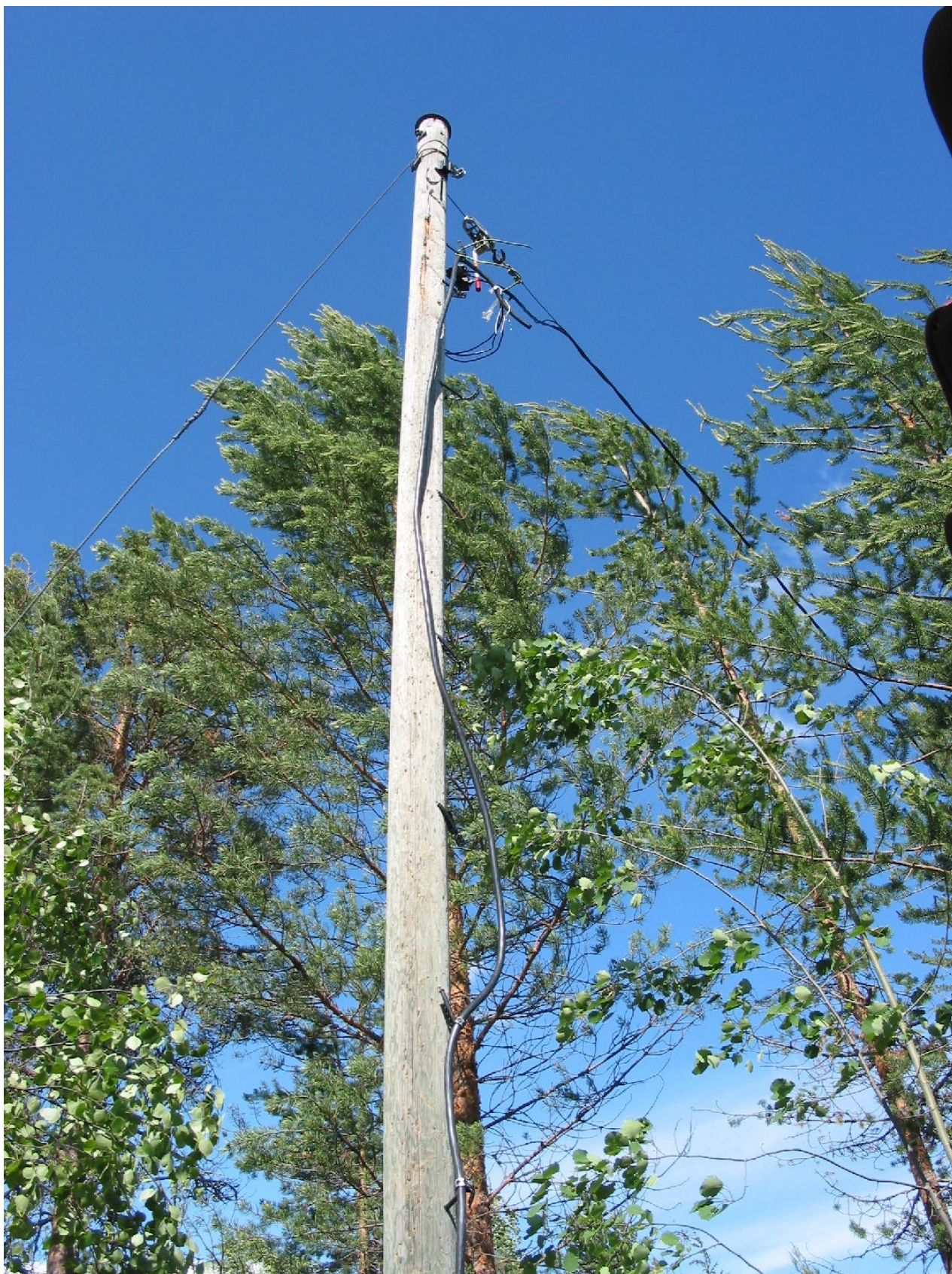
Kuva 1 AMKA kiinnitettynä pylvääseen taljan ja sammakon avulla. Vapaa-ajan asunnon liittymiskaapelin irronnut PEN-johdin näkyy ylhäällä, koukun oikealla puolella
