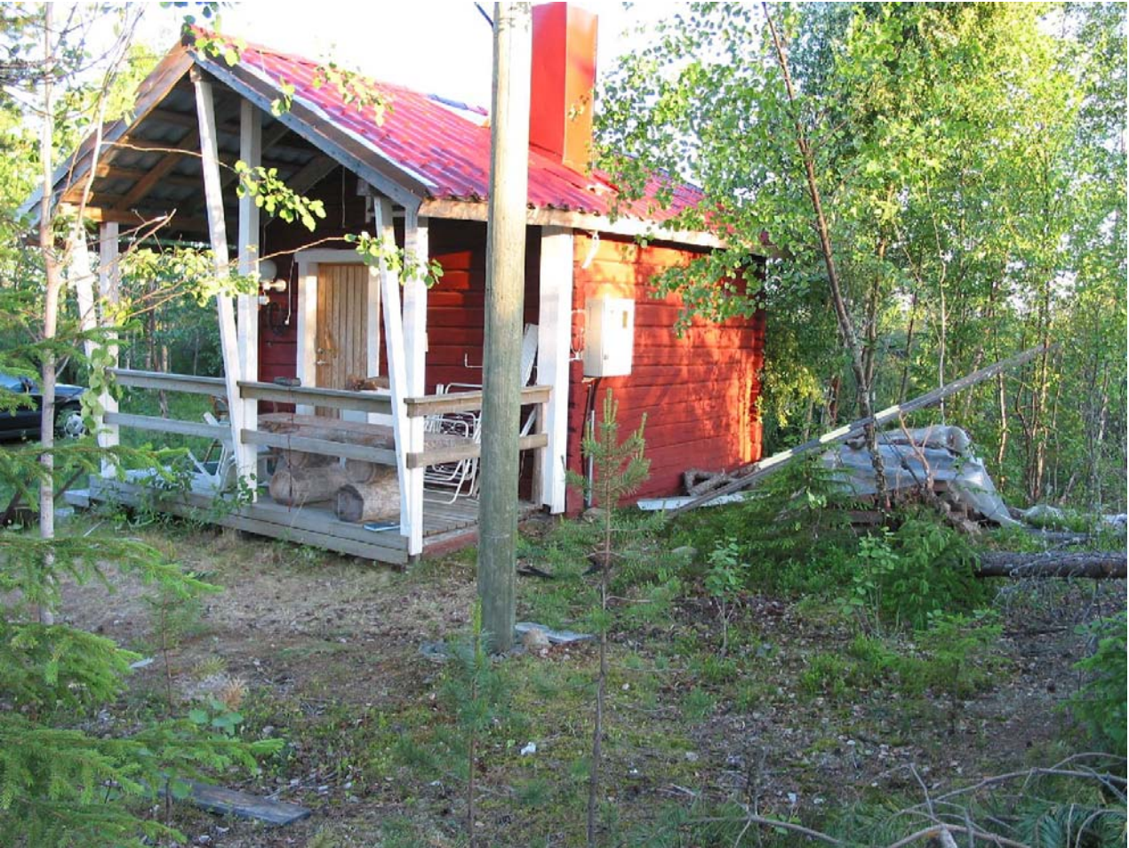
Kuva 3 Vapaa-ajan asunnon pääkeskus, jonka pääkytkin oli kiinniasennossa. Päätepylväs näkyy etualalla
