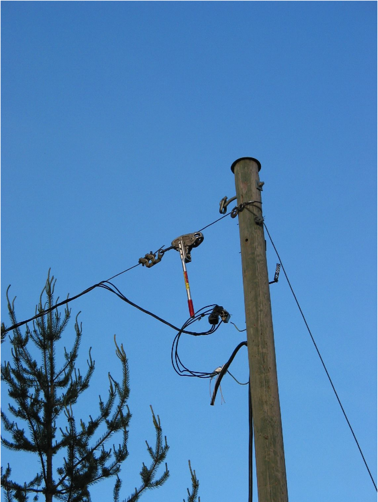
Kuva 2 Johto ja päätepylväs kuvattuna toiselta puolelta. Sammakko ja talja näkyvät hyvin.
