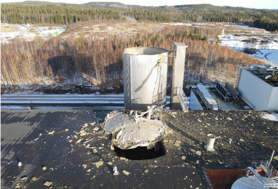
Kuva 3 Massatorni ja massatornin katto viereisen tehdasrakennuksen katolla välittömästi onnettomuuden jälkeen (Kuva: Pohjois-Savon pelastuslaitos)
