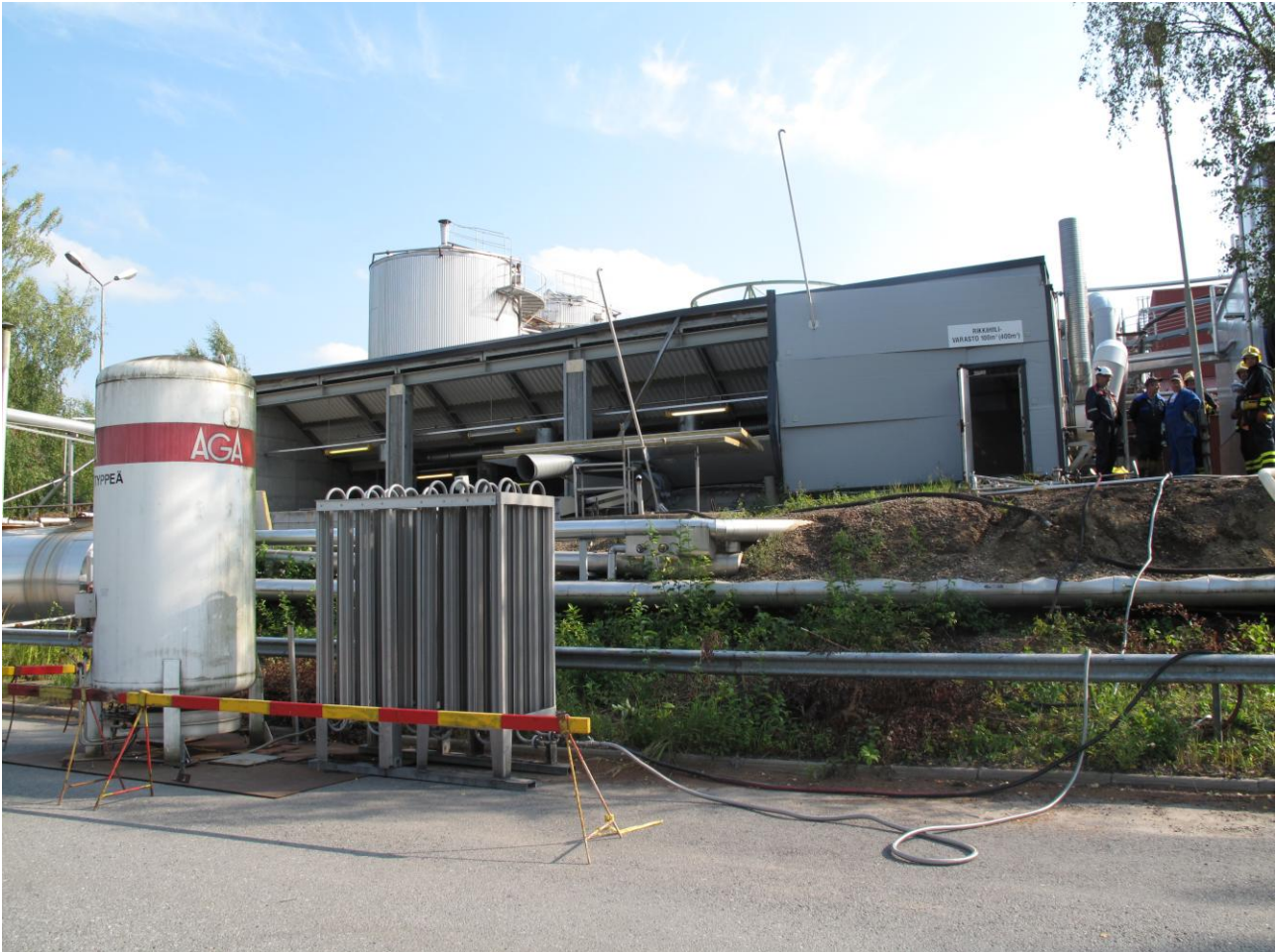
Kuva 4. Typpiasema ja takana rikkihiilivarasto. Aktiivihiilisuodattimet sijaitsivat typpiaseman oikealla puolella (ei näy kuvassa).
