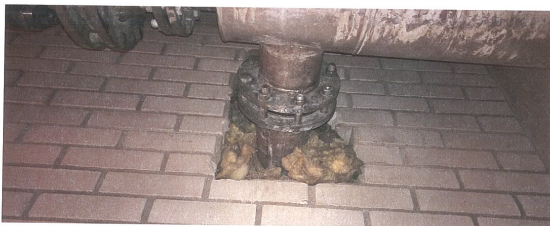
Kuva 5. Laippaliitos, johon murtolevyä vaihdettiin.
