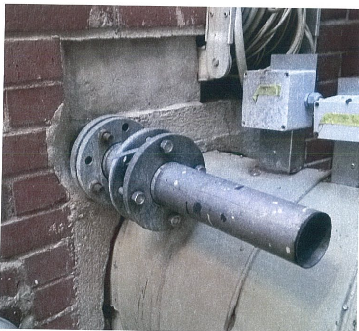
Kuva 1. Murtolevyn ulospuhallusputki.
