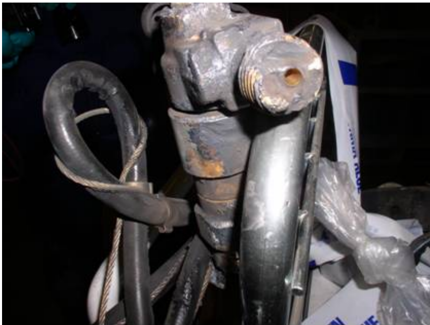
Kuva 7 Pulloventtiili onnettomuuden jälkeen
