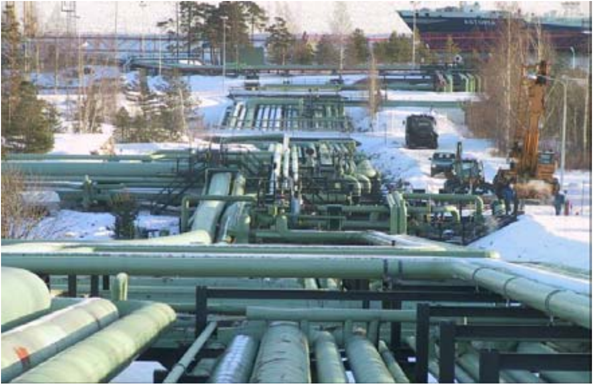
Kuva 1. Laivauslinjat, vuoto kohta kuvan keskellä olevassa putkessa.
