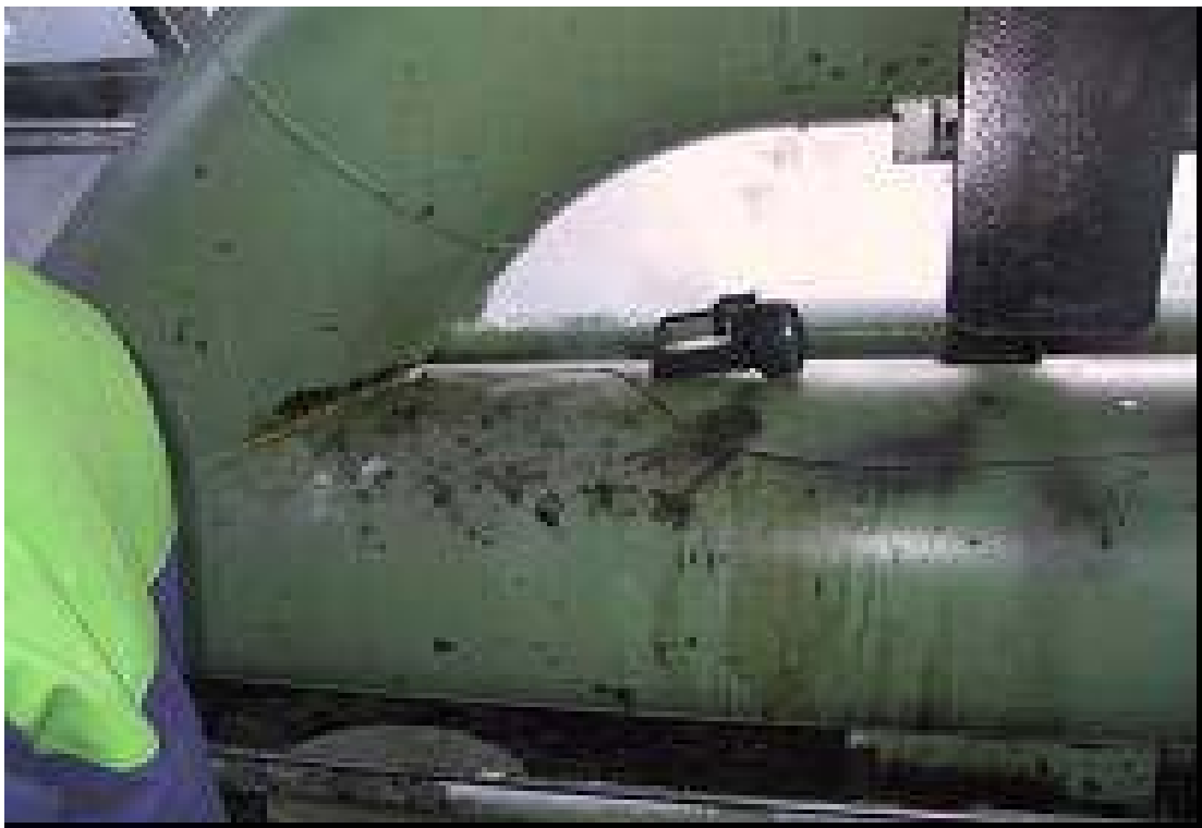
Kuva 4. Suorassa putkessa oleva 1,5 metrin murtumahaara
