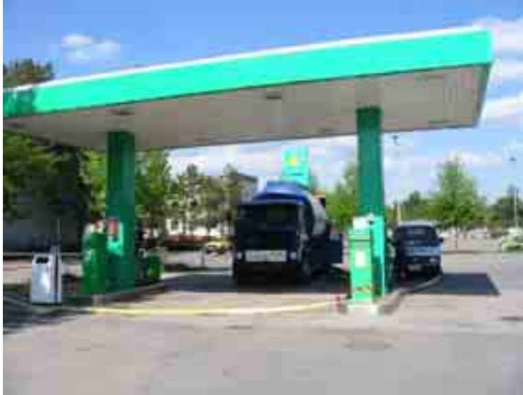
Kuva 1. Jakeluaseman onnettomuussäiliö sijaitsee säilöajoneuvon vieressä maan alla.
