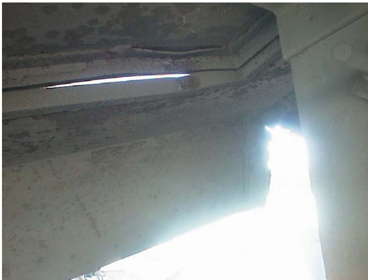
Asfalttikoneen sisäosa räjähdysen jälkeen
