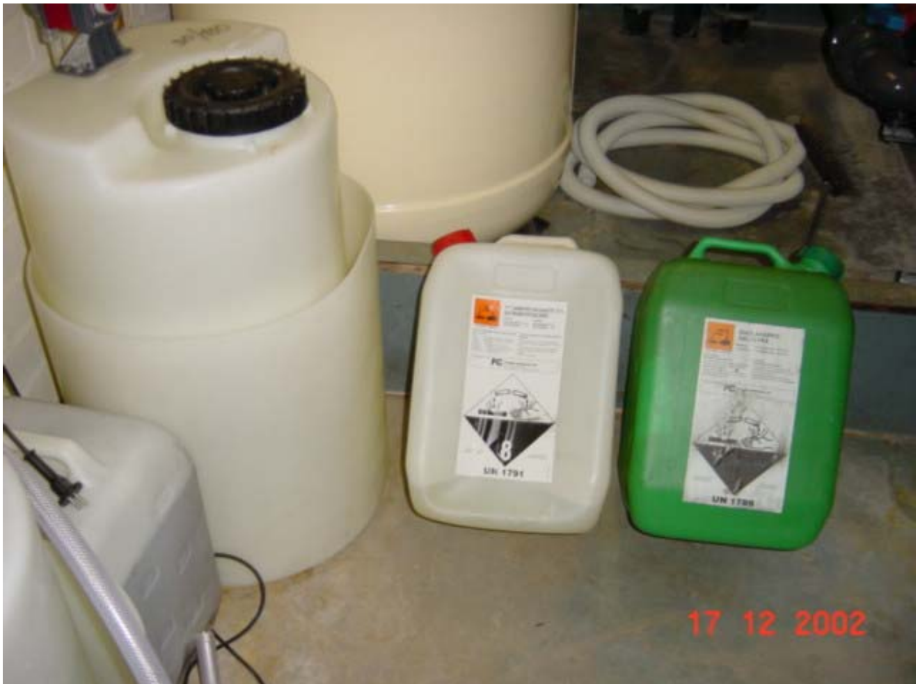
Kuva 1. Natriumhypokloriittisäiliö ja natriumhypokloriitti- ja suolahappokanisterit.
