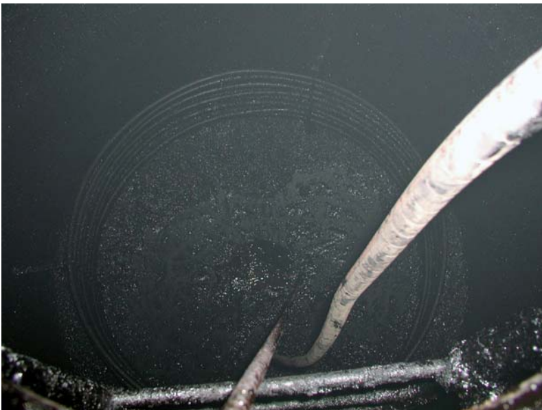
Kuva 4. Säiliö 224S kuvattuna miesluukulta alaspäin.
