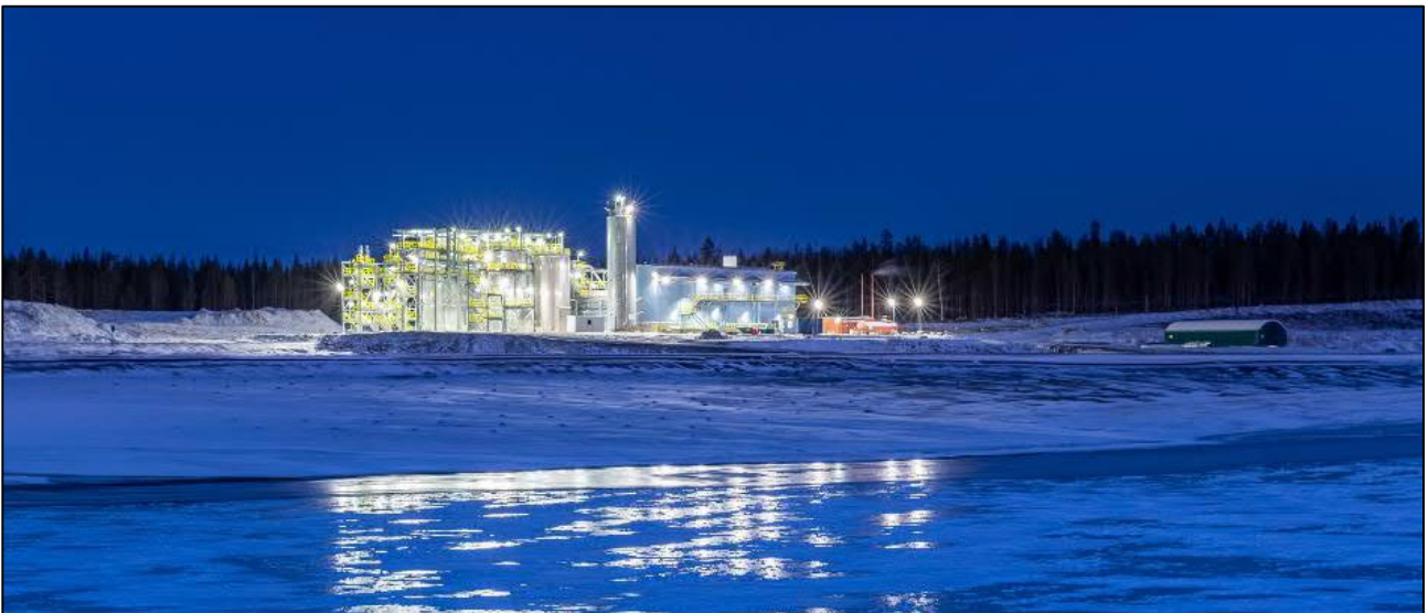
Kuva 16. Vesienkäsittelylaitos. (Kuva: Agnico Eagle Finland Oy)
