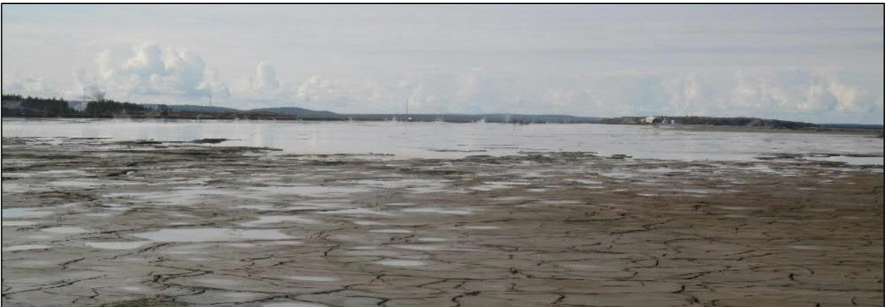
Kuva 8. NP3-rikastushiekka-allas. (Kuva: Agnico Eagle Finland Oy)
