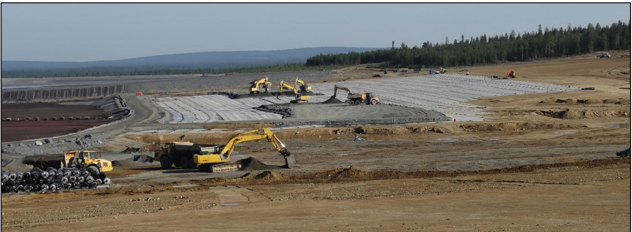
Kuva 21. Vesivarastoaltaan rakentamista. (Kuva: Agnico Eagle Finland Oy)
